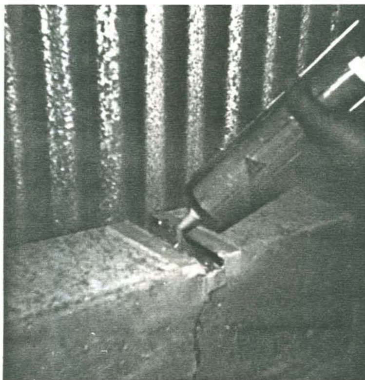
Fotografia 3.5 - Proteção das bordas do berço com fita crepe. Uso da fita crepe no fundo do berço para que o mastique esteja aderido apenas nas laterais do berço
