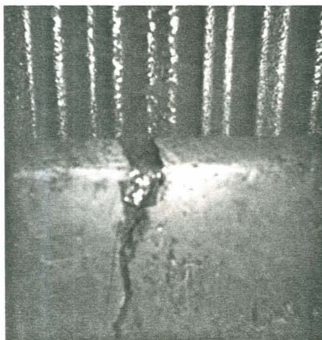
Fotografia 3.6 - Aspecto final da fissura corrigida
