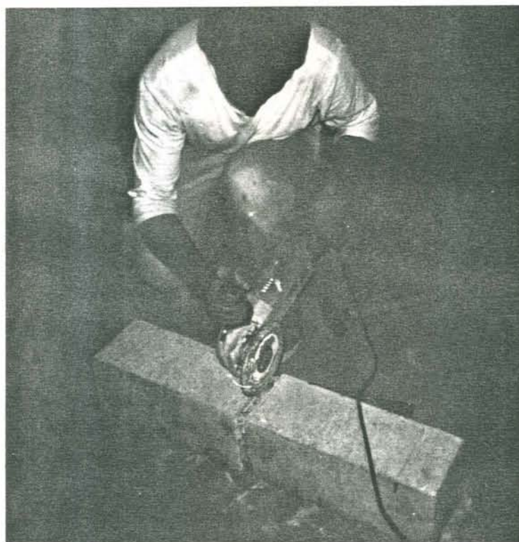
Fotografia 3.3 - Abertura de berço com disco de corte para posterior preenchimento com masticque
