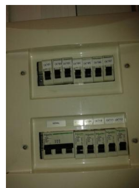
Figura 9: Rede de tomadas nas salas de aula Figura 10: Central de disjuntores das tomadas de sala de aula
