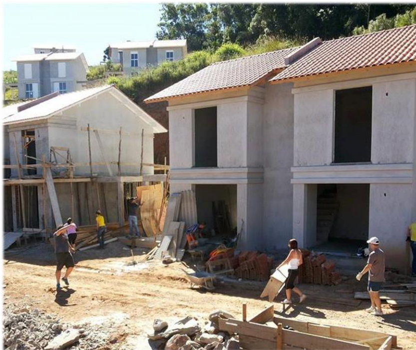
Figura 6: Sobrados da Cooperativa Habitacional Casa Nostra na etapa de obras. Fonte: acervo da autora, 2015.
