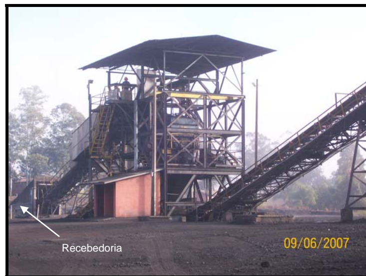
Figura 7. Unidade de britagem com a recebedoria do carvão ROM.
