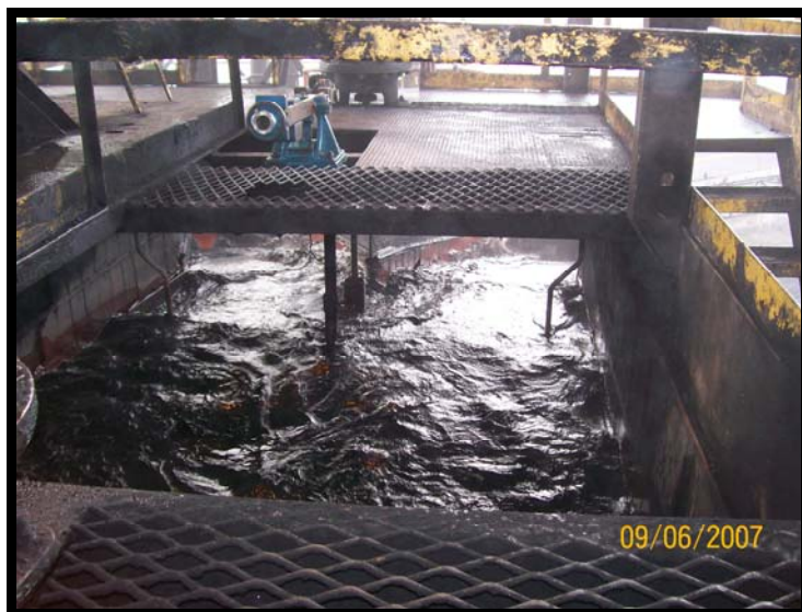
Figura 10. Vista do leito do jigue.
