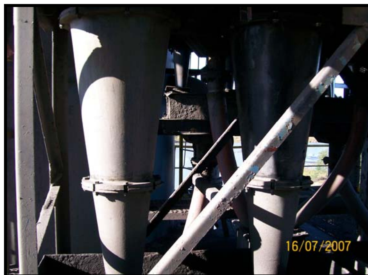
Figura 13. Hidrociclones deslamadores.
