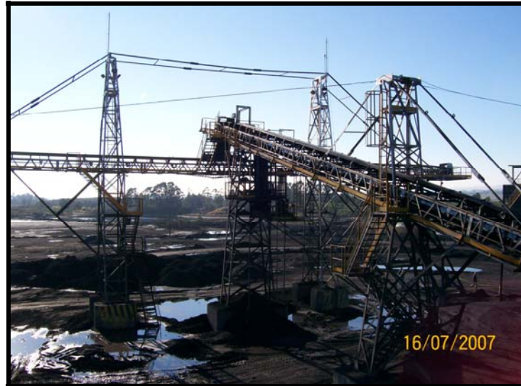
Figura 12. Sistema de estocagem do carvão britado.
