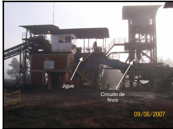
Figura 8. Vistas da Unidade de Lavagem onde se vêem os prédios do jigue (ao centro na foto) e do circuito de finos (à direita na foto).
