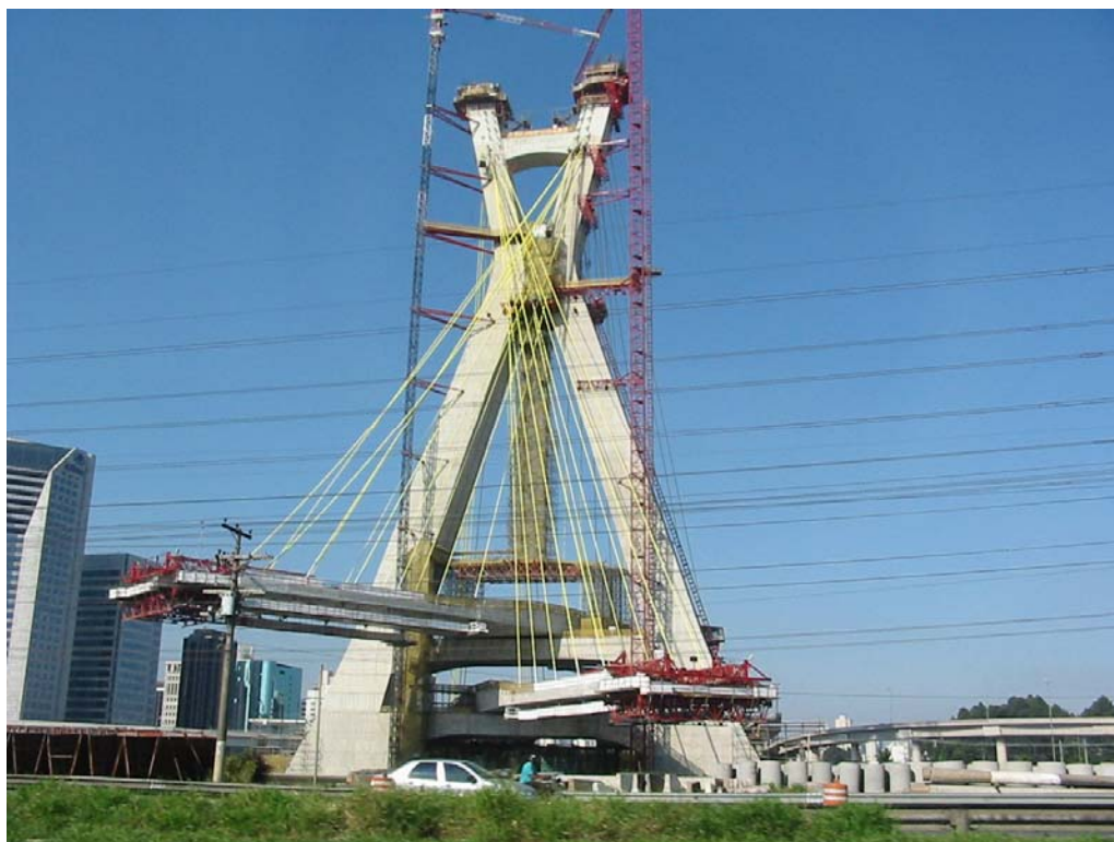
Figura 78: construção dos tabuleiros das pontes em avanços sucessivos
