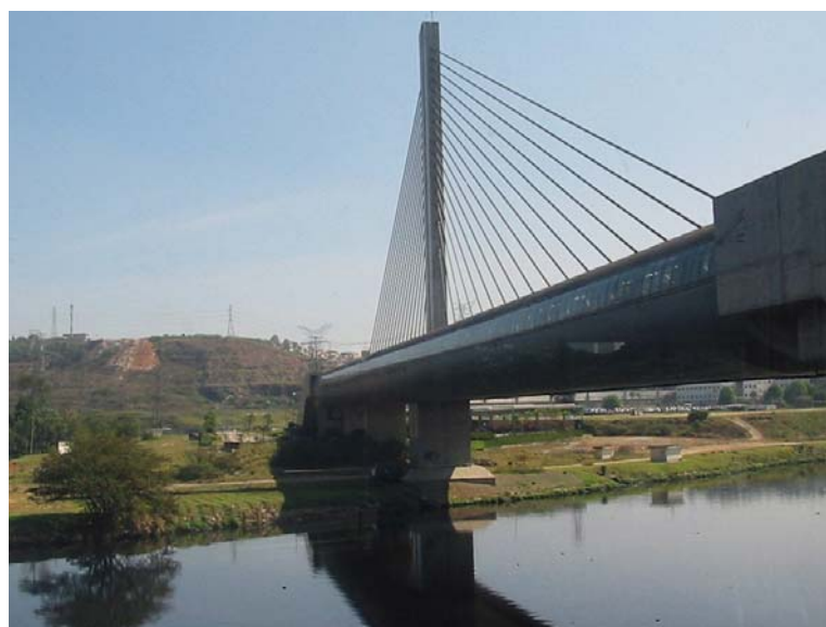
Figura 1: Ponte Eng. Jamil Sabino e estação de trem / SP
