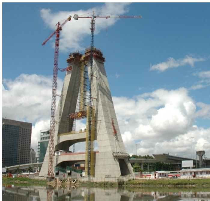
Figura 77: construção do pilar das pontes
