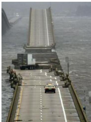
Figura 96: ponte de acesso segmentada pelo vento – EUA
