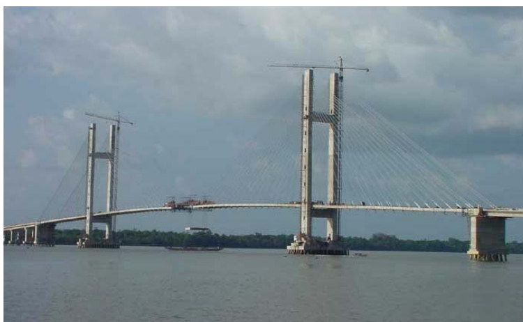
Figura 65: colocação da última aduela pré-moldada da Ponte Guamá
