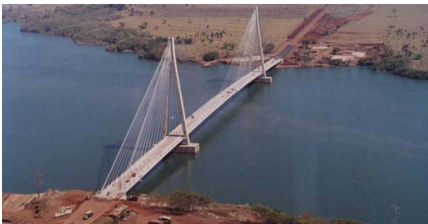
Figura 66: foto aérea da Ponte Paulicéia com estrutura concluída
