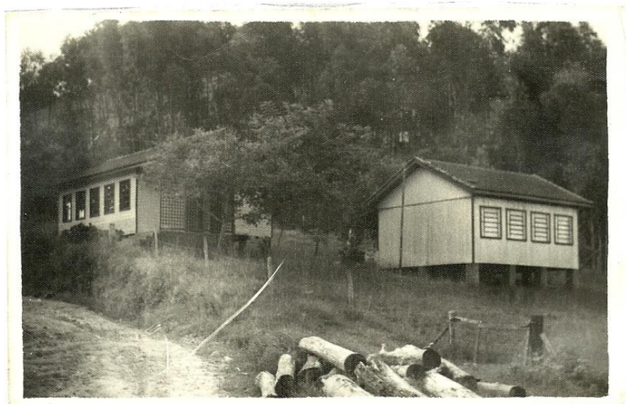
Figura 6 - Os primeiros prédios construídos. Primeiro foi construído o prédio à esquerda, depois o da direita
