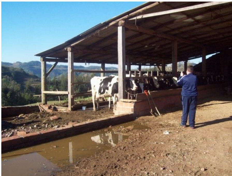
Figura 59 - Problemas na localidade rural, estábulo com acúmulo de água e umidade
