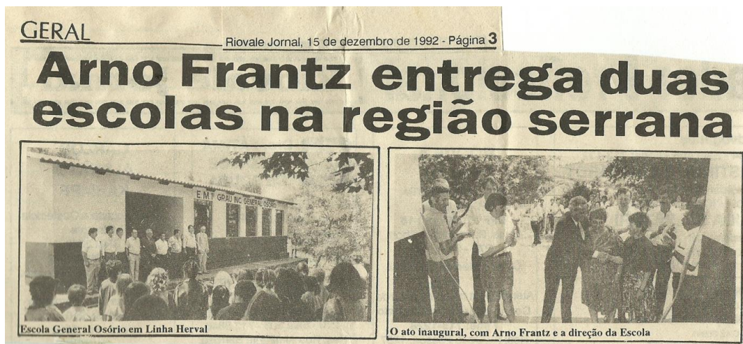
Figura 7 - Inauguração do novo prédio da Escola
