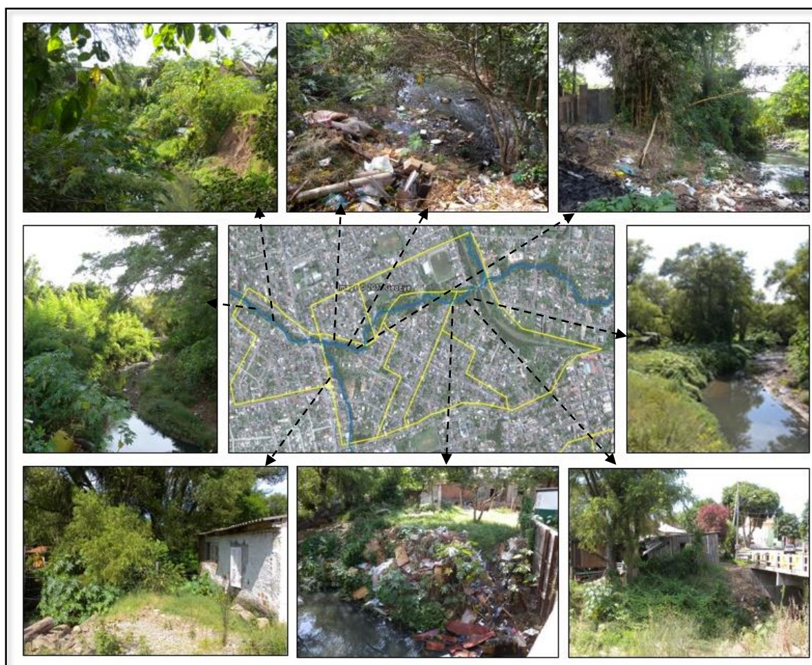
Figura 79: Ocupação e situações de ameaça junto à Setores Censitários da zona administrativa Norte. É possível verificar a proximidade das moradias em relação ao canal fluvial, a erosão das margens é intensa devido às modificações no terreno, o assoreamento é incrementado pelo acúmulo de lixo junto ao leito. Fonte trabalhos de campo, março de 2013.
