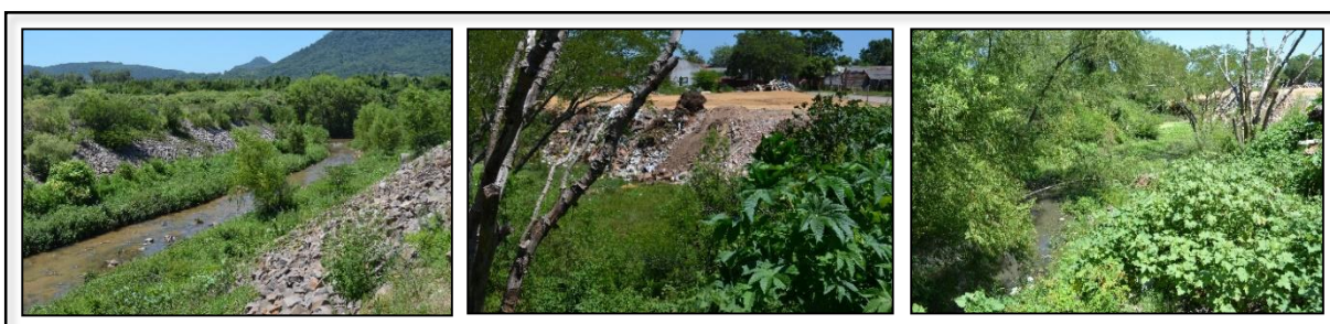
Figura 61: Porção final da canalização do arroio Cadena junto ao Setor Censitário 431690705120019. Fonte: Trabalhos de campo, março de 2013.
