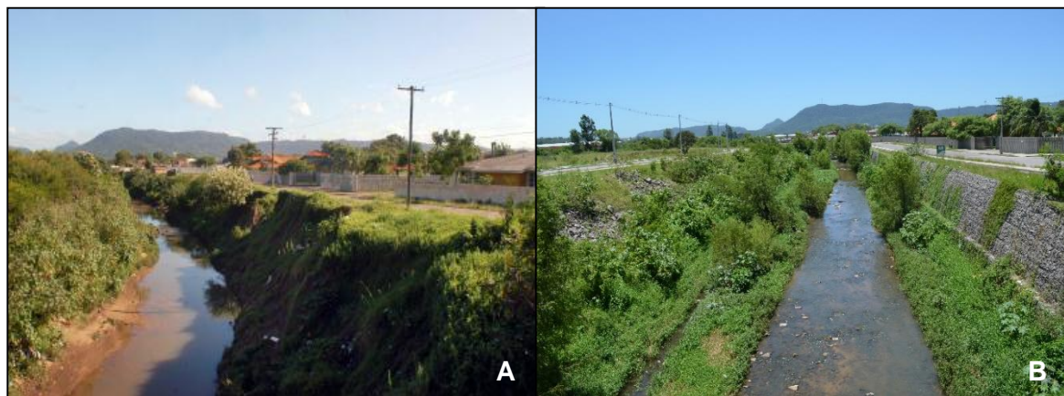
Figura 81: Arroio Cadena antes (A) e depois (B) da canalização. Fonte: Oliveira (2004).
