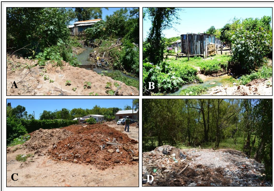
Figura 62: Situações de ameaça e risco aos processos de dinâmica fluvial junto aos Setores Censitários 431690705120005 e 431690705120001. Em ‘A’ e ‘B’ é possível observar a proximidade das moradias do canal e seu padrão construtivo (muito baixo); em ‘C’ e ‘D’ verifica-se a construção de aterros em direção às antigas cavas de extração de argila. Fonte: Trabalhos de campo, março de 2013.
