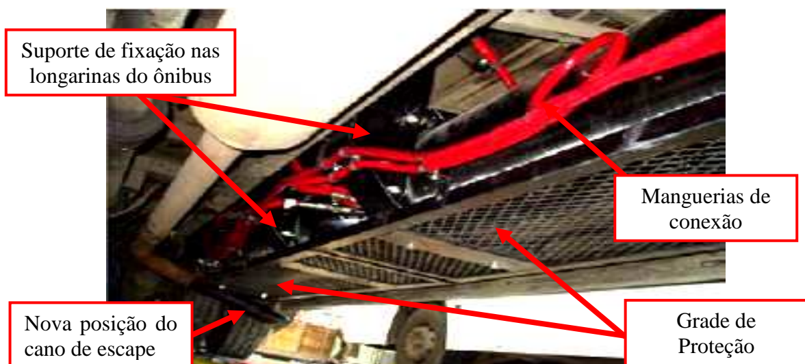
Figura 4.5: Cilindros de armazenamento fixados sob o assoalho do GASBUS.
