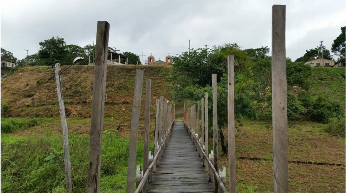
Figura 2 – Passarela que dá acesso às escadas de Cameté do Ramos (distrito de Barreirinha-AM)
