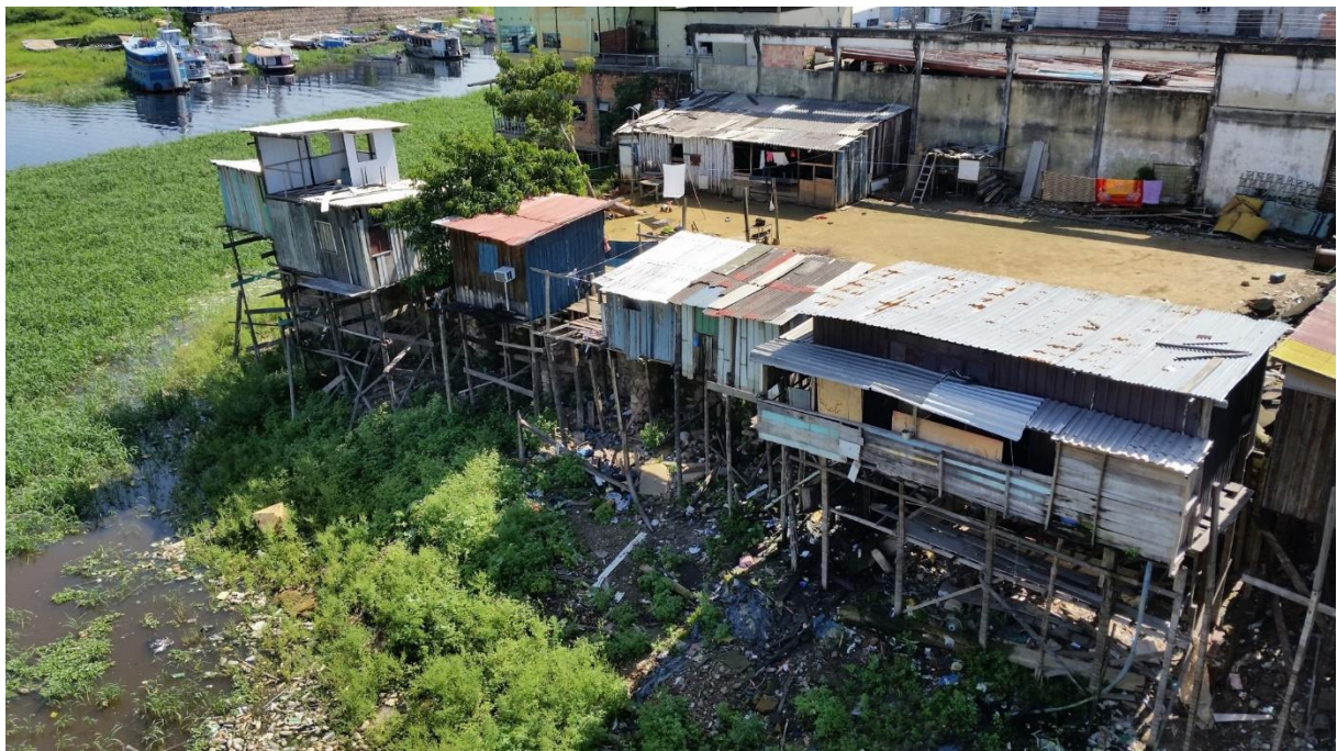
Figura 14 – Aproximando-me da residência do Diquinho do Sax, bairro Educandos, Zona Sul (28.01.2015)
