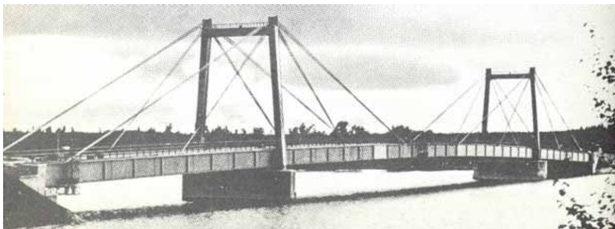
Figura 1.2 - Ponte Strömsund, Suécia - possuía arranjo de cabo duplo e consequentemente grande espaçamento entre eles (Troitsky, 1977).
