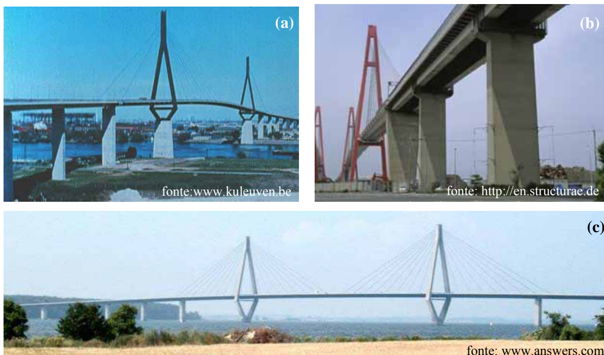
Figura 1.3 - Fotografias de pontes estaiadas em que foram observadas vibrações nos cabos devido ao efeito combinado de chuva e vento (a) ponte Köhlbrand; (b) ponte Meiko Nishi; (c) ponte Farø.
