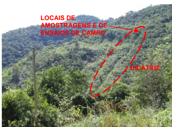
Foto 3.1: Vista geral da encosta com destaque para cicatriz originada pelas corridas de detritos de dezembro de 2000
