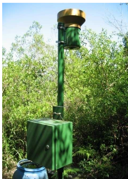
Foto 4.19: Pluviômetro instalado na encosta estudada (cota 372 m)
