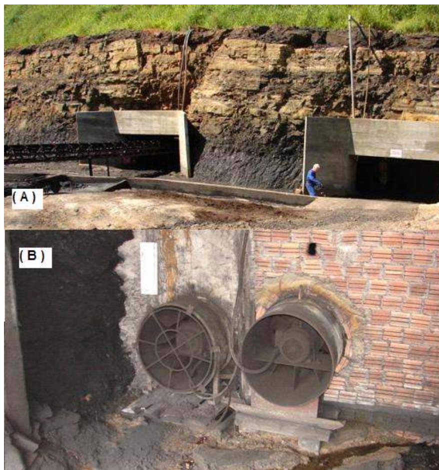
Figura 13 - (A) Ilustração de uma típica mina de carvão, com entrada principal, saída do carvão por esteiras e, (B) saída do ar viciado (sujo), por exaustão.
