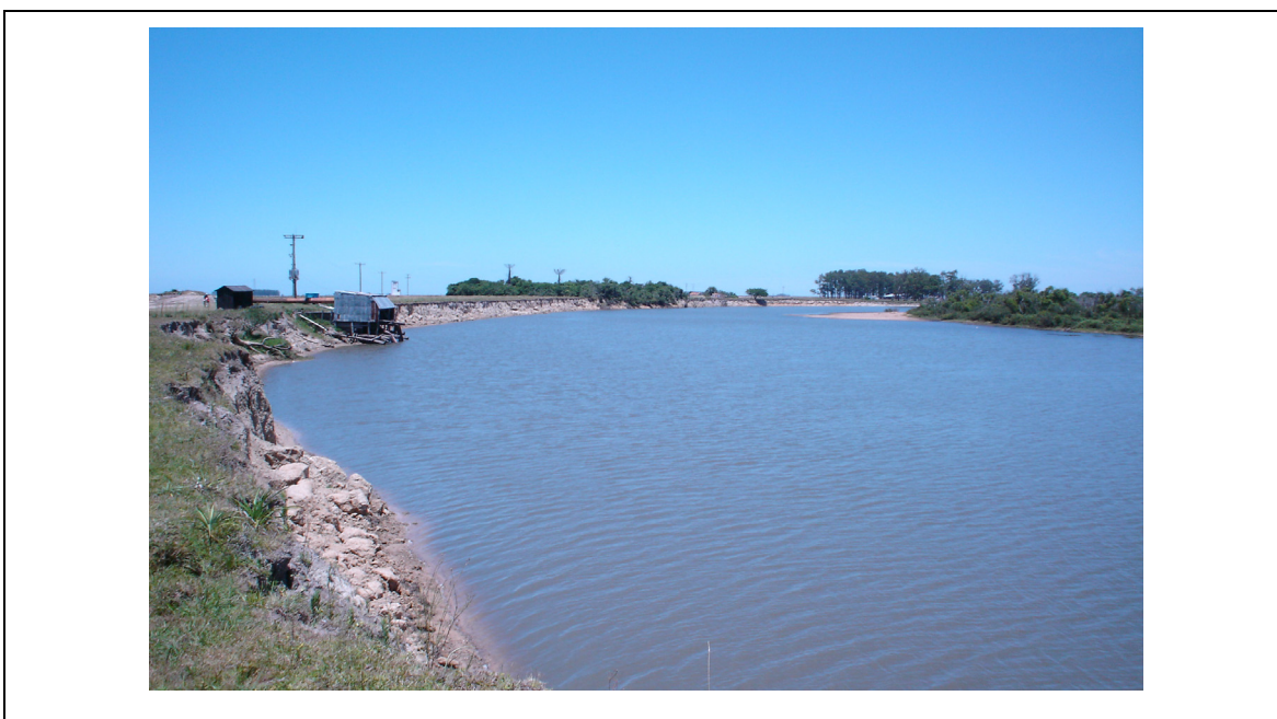
Figura 45 – Falésias associado a Barreira III gerado pela erosão marginal do rio Piratini (UTM WGS 84 – 359326 E 6459411 N).
