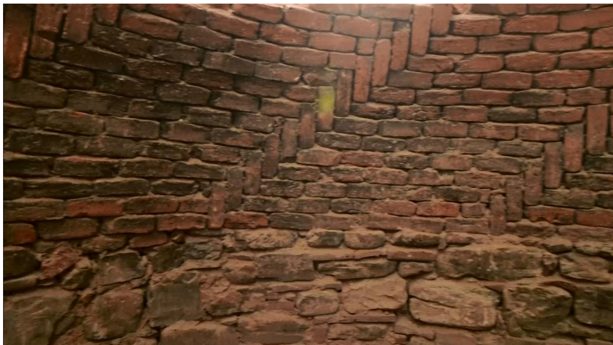
Figura 7 – Cupolina mostrando a base de arenito e o padrão da alvenaria da cúpula (nota-se que ela é circular, e não octogonal)
