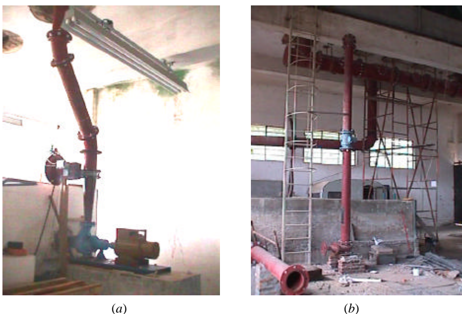
FIGURA 4. 14. Vista dos trechos (a) inferior (no primeiro andar) e (b) superior (no segundo andar) da bancada do LEH.
