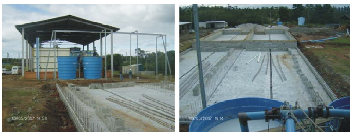
Figura 26 - Construção de leitos de secagem do lodo
