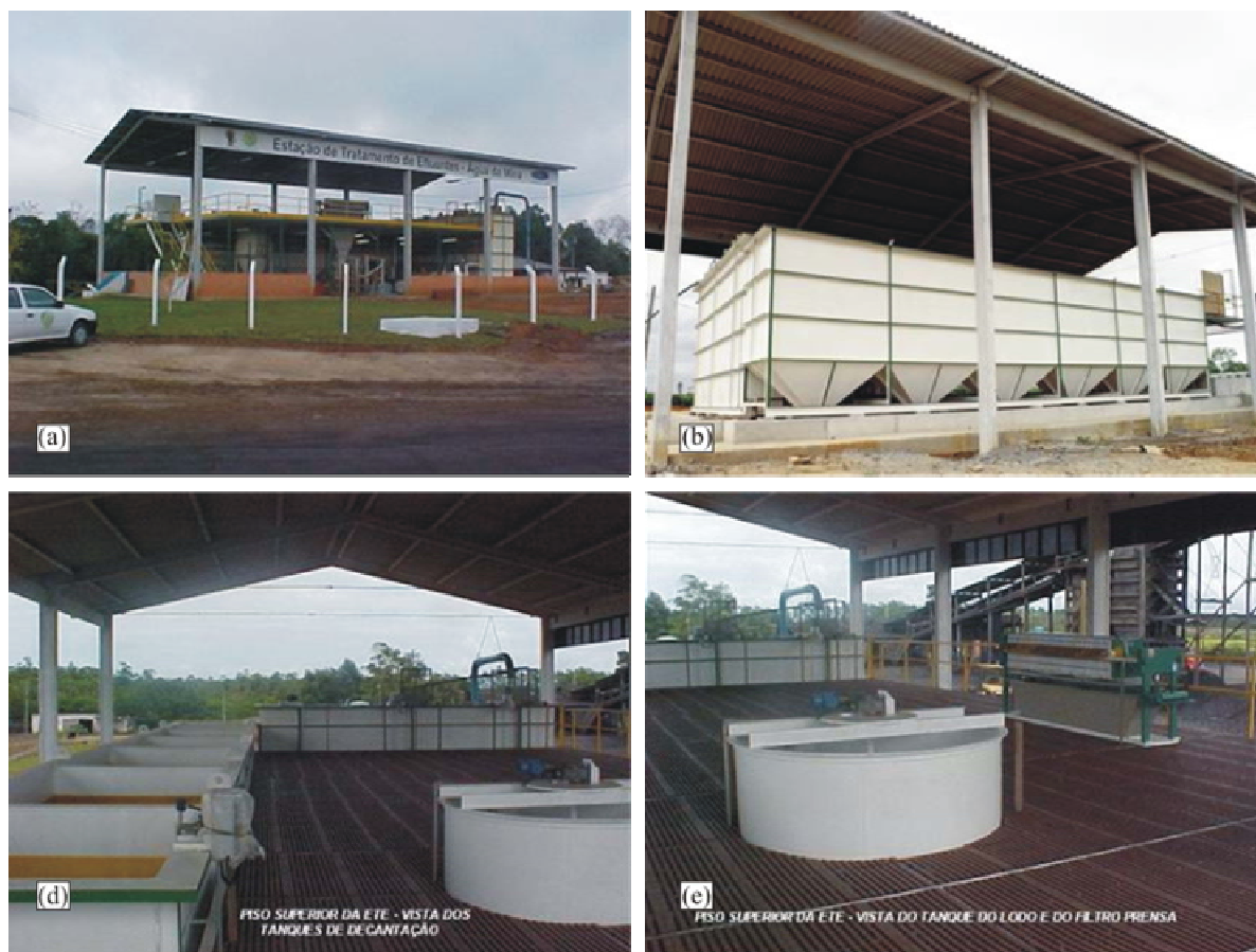
Figura 22 – Projeto inicial da ETDAM Cooperminas – (a) Vista geral da ETDAM, (b) Vista dos decantadores, (c) Vista superior dos decantadores (Piso superior da ETDAM) e (d) Vista do tanque de lodo e filtro prensa (Piso superior da ETDAM)
