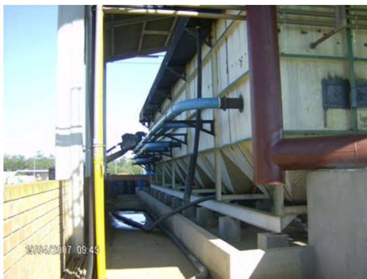
Figura 24 – Distribuição do fluxo nos seis decantadores existentes
