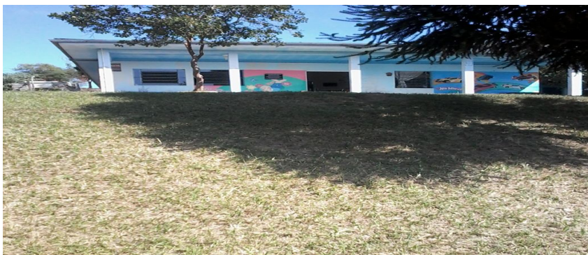
Foto 13: Pátio frente com barranco
