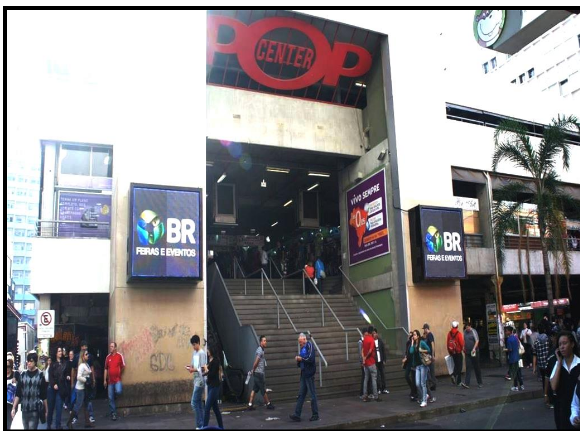
Figura 6 - Pop Center, entrada principal pela Rua Voluntários da Pátria
