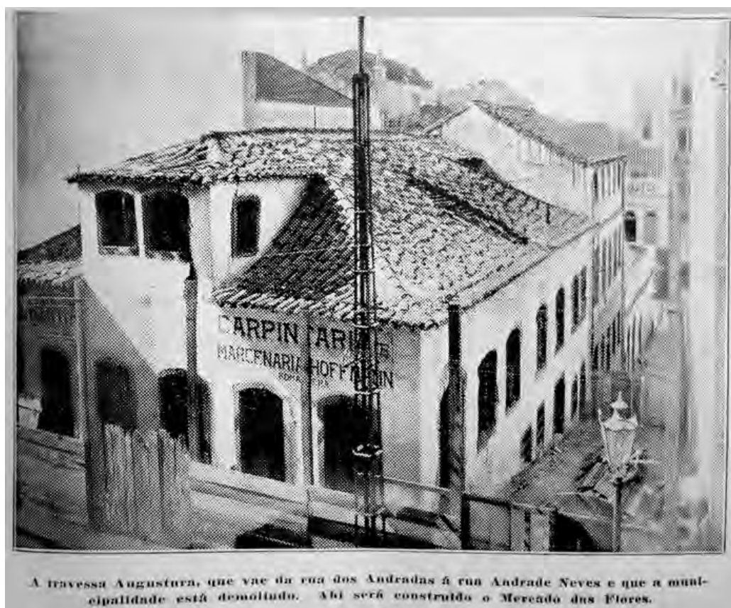
Figura 45: Travessa Angustura já no início de sua demolição. Fotografia da Revista "A Mascara", 06/02/1925. Hemeroteca do Museu de Comunicação Social Hipólito José da Costa.
