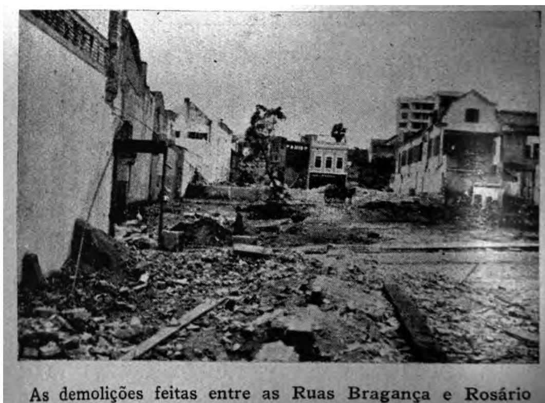
Figura 76: Demolições na antiga Travessa 2 de Fevereiro entre a atual rua Marechal Floriano Peixoto (Rua de Bragança) e Vigário José Inácio (Rua do Rosário). Porto Alegre: Biografia duma Cidade, 1941.
