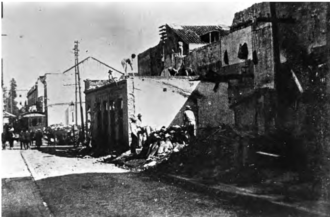
Figura 72: Demolição Beco do Rosário. Fototeca do Museu Hipólito José da Costa.
