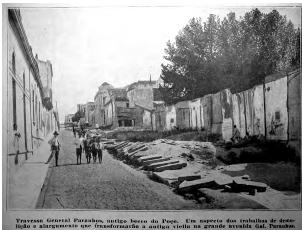
Figura 54: Fotografia da demolição da "Travessa" General Paranhos na revista "A Mascara", de 06/02/1925. A fileira de edificações à esquerda parecer se de casas térreas, possivelmente de aluguel.
