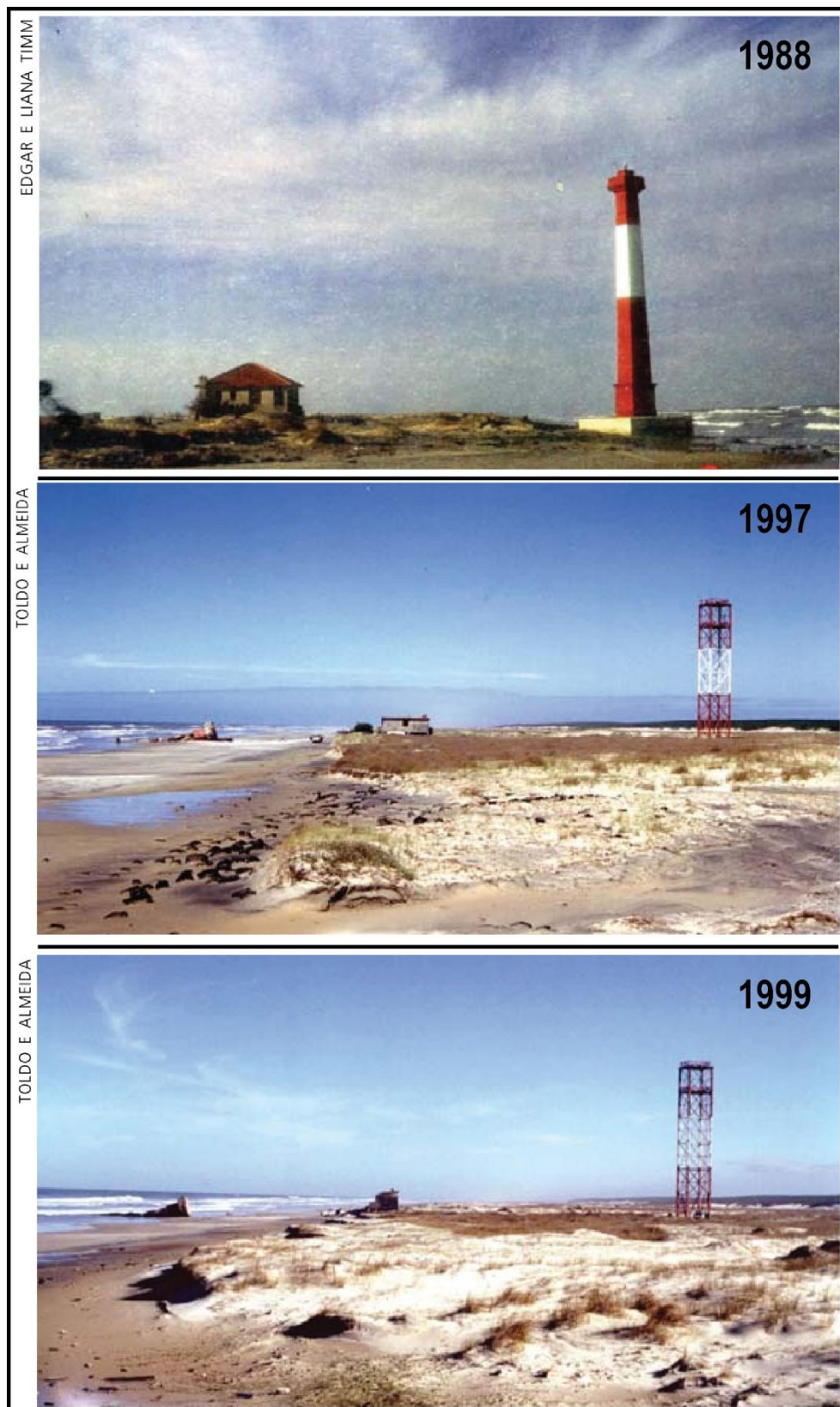
Figura 8: Erosão costeira no Farol da Conceição no trecho transgressivo do Litoral Médio do RS. Foto de 1988 com o velho farol e a casa logo atrás; foto de 1997 com o velho farol destruído; foto de 1999 com a casa que se encontrava atrás do velho farol destruída (modificado da Toldo Jr. et al. , 2006).
