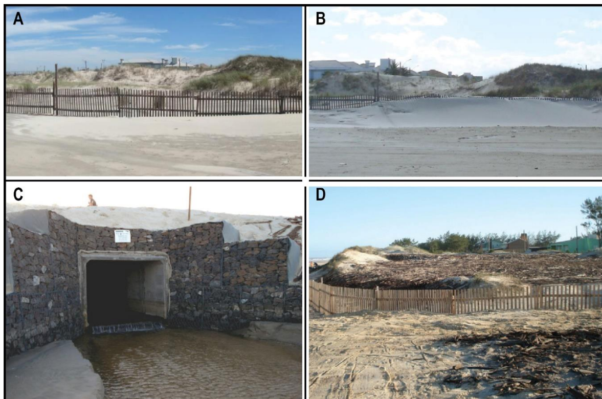
Figura 10: Recuperação das dunas frontais no litoral norte do RS: A) início da recuperação das dunas frontais; B) acúmulo de sedimentos pelo transporte eólico; C) canalização dos sangradouros para evitar a erosão das dunas, D) recuperação das dunas sob a canalização (A e B modificado de Portz, 2012; C e D modificado de Tabajara & Weschenfelder, 2011).
