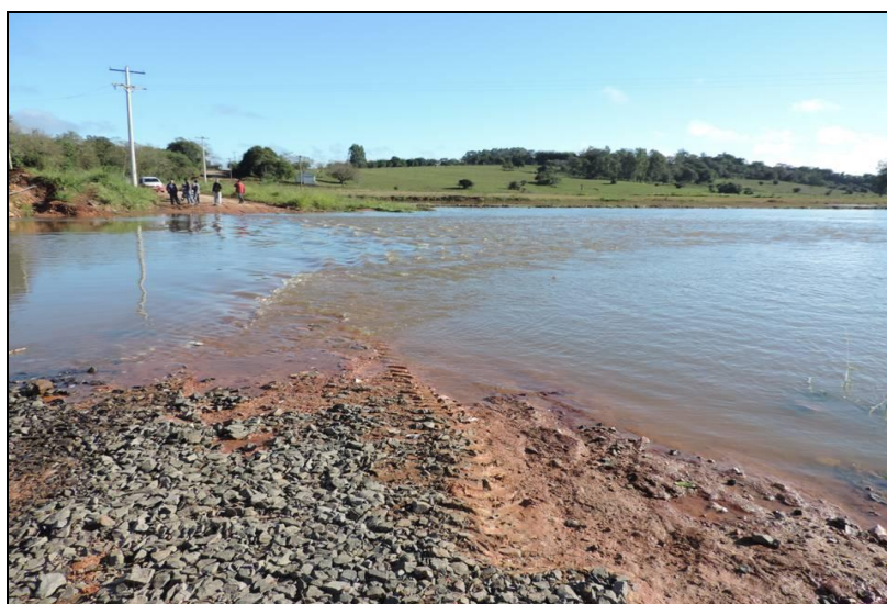
Figura 23: Estrada interditada no município de Rio Pardo por inundação. Fonte: Pesquisa de Campo, 2015. Acervo próprio.
