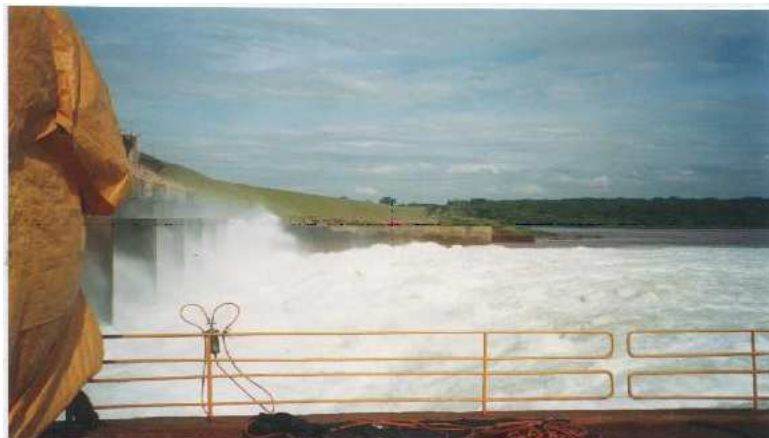
Figura 2.2: Ressalto hidráulico formado na UHE de Porto Colômbia, vazão de 4\,000\text{ m}^3\text{s}^{-1} , com número de Froude igual a 4,3 – Marques et al. (1999).
