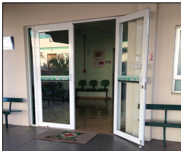
Figura 33 - Adesivos nas esquadrias de acesso
