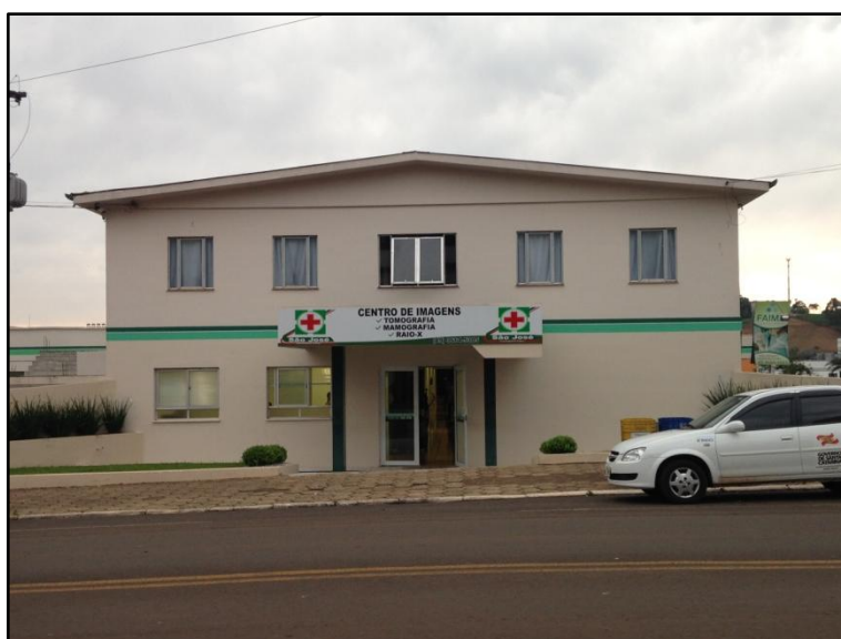
Figura 28 - Acesso para o Centro de Imagem
