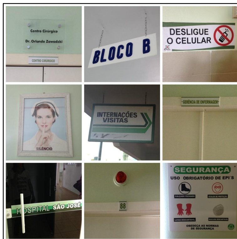
Figura 39 - Irregularidade nos elementos de sinalização
