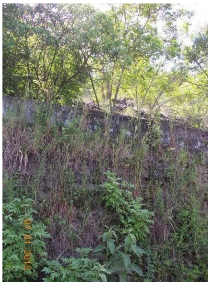
Figura 29: Muro de arrimo existente a esquerda da rodovia entre o km 44+000 e o km 46+000, no sentido São Vendelino – Nova Milano.
