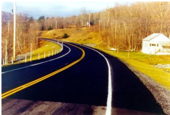
Figura 11: Vista final da estrada após utilização de aterro com EPS (GEOFOAM RESEARCH CENTER, 2000).
