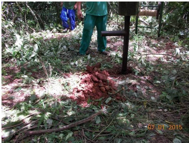
Figura 38: Execução da sondagem no ponto SPT01.
