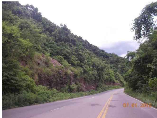
Figura 34: Imagem da seção analisada no sentido Nova Milano – São Vendelino, sentido contrário do estaqueamento.
