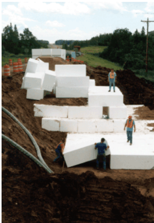
Figura 13: Detalhes do processo executivo (GEOFOAM RESEARCH CENTER, 2000).
