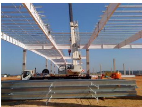
Figura 28: Montagem terças
