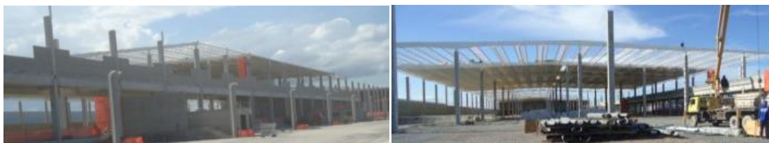
Figura 17: Vistas lateral e frontal – obra B
