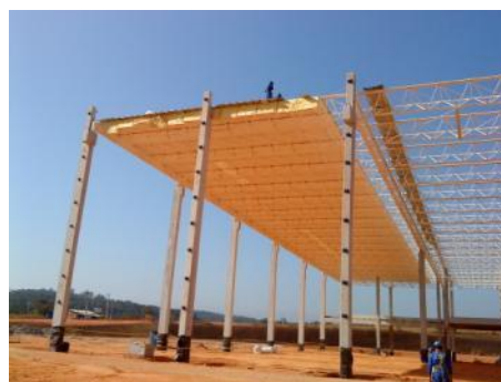
Figura 31: Montagem telhas de cobertura
