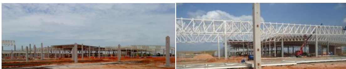
Figura 13: Frente de serviço - obra A
