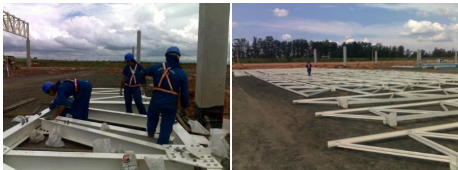
Figura 40: Pré-montagem da treliça principal e das treliças planas (estrutura secundária)
