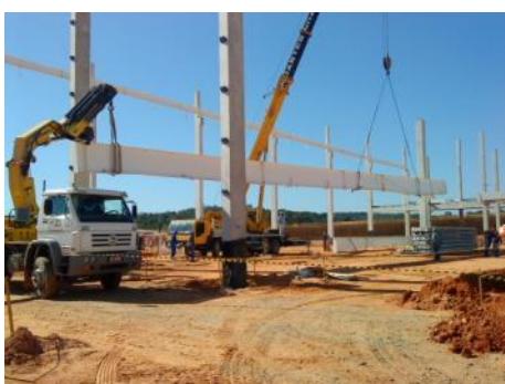
Figura 27: Montagem estrutura principal
