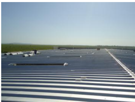
Figura 32: Montagem sistemas de iluminação, ventilação e calhas e arremates
