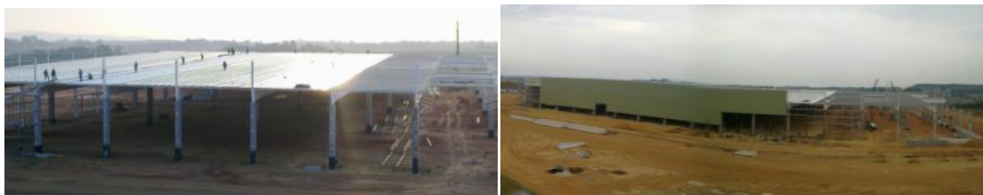
Figura 21: Vistas laterais - obra D
