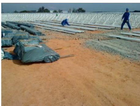
Figura 26: Pré-montagem treliças
