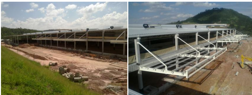
Figura 23: Vistas laterais – obra E
