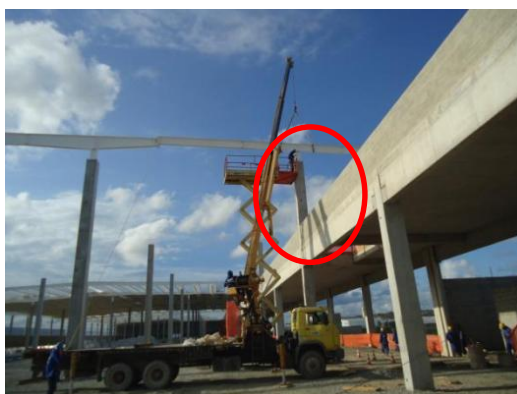
Figura 47: Retrabalho na viga de cobertura Z
