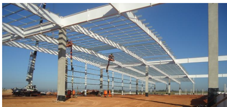
Figura 87: Atividade de alinhamento da estrutura de cobertura
