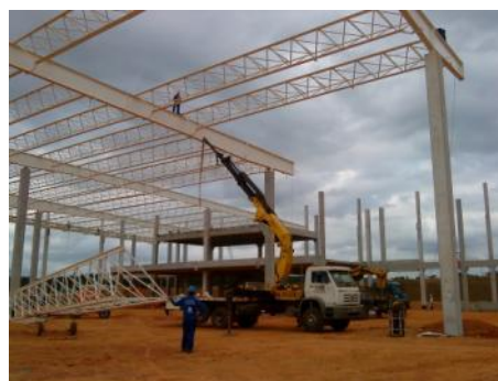
Figura 29: Montagem das treliças
