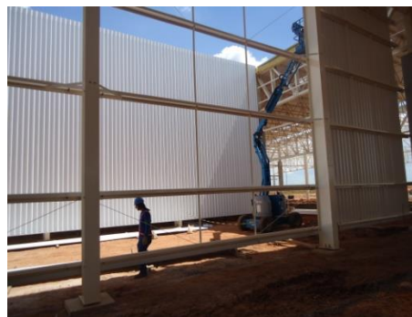
Figura 33: Montagem estrutura e telhas de fechamento latera
