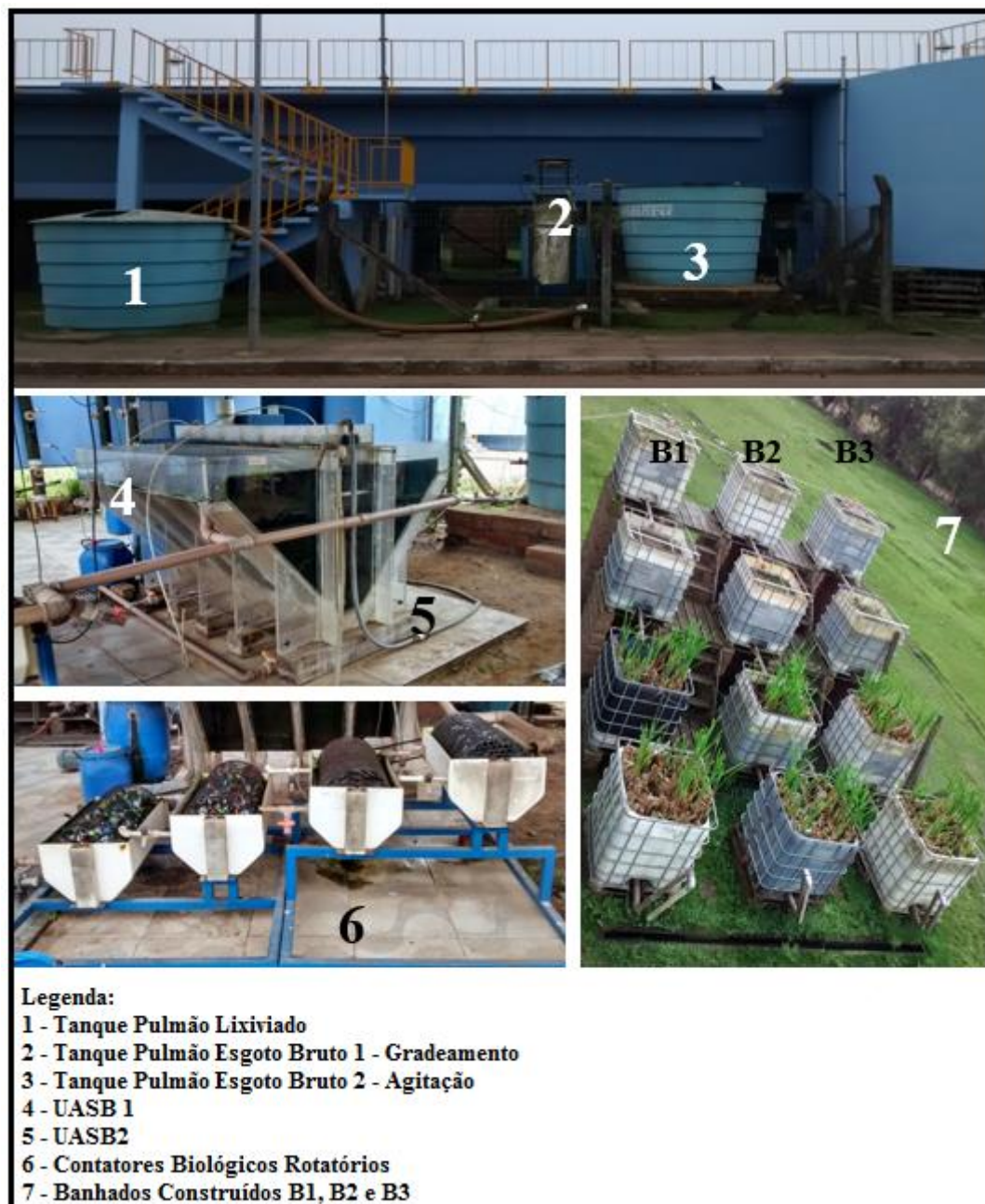
Figura 18 - Unidades experimentais da estação piloto do IPH/UFRGS na ETE Canoas
