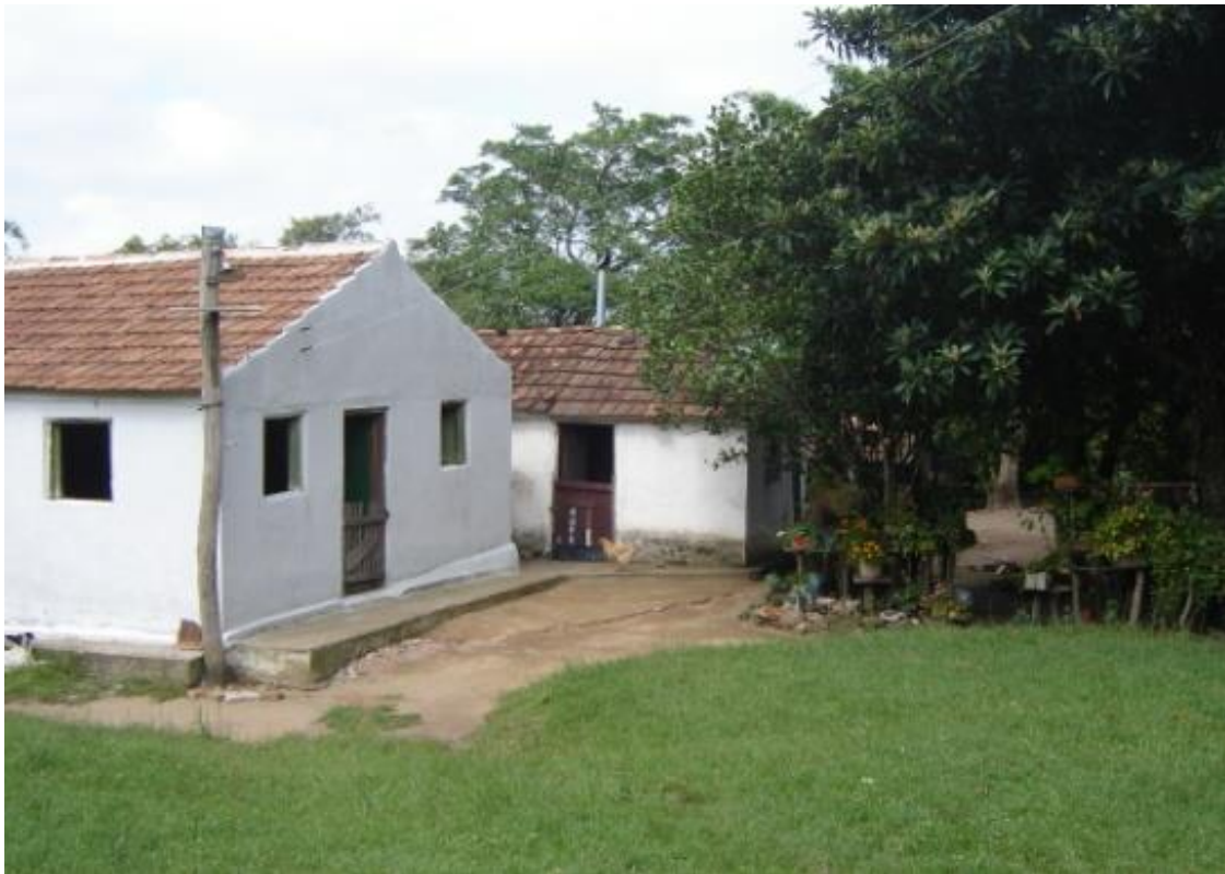
Elementos da vida rural: velhas construções, jardins e animais. Localidade Rincão dos Maia, Canguçu/RS, 2008. Foto: Deise Lisboa Riquinho.
