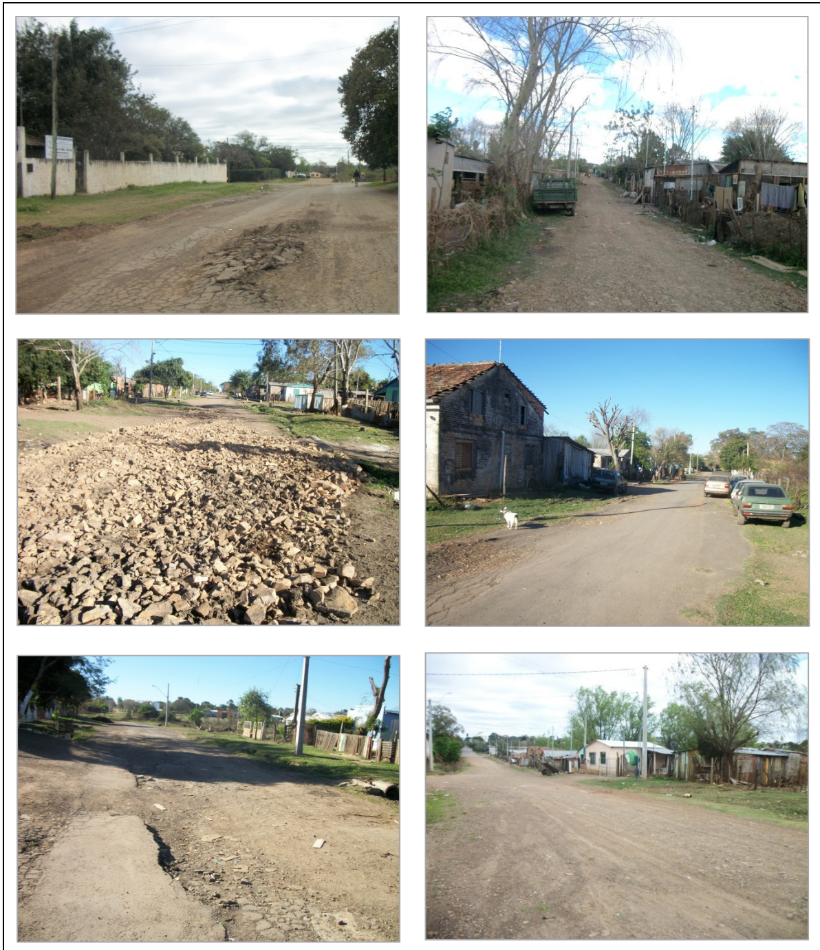
Figura 6.15: Condições dos arruamentos nos bairros de Uruguaiana atingidos por inundações. Fonte: Trabalho de campo – Fevereiro/2015.
