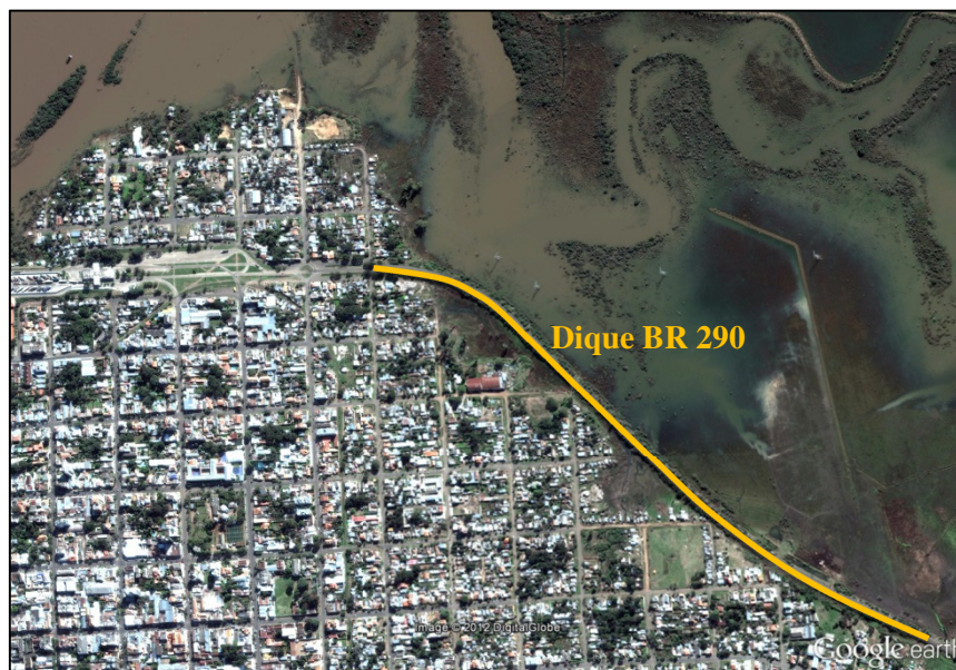
Figura 5.31: Dique da BR 290.
