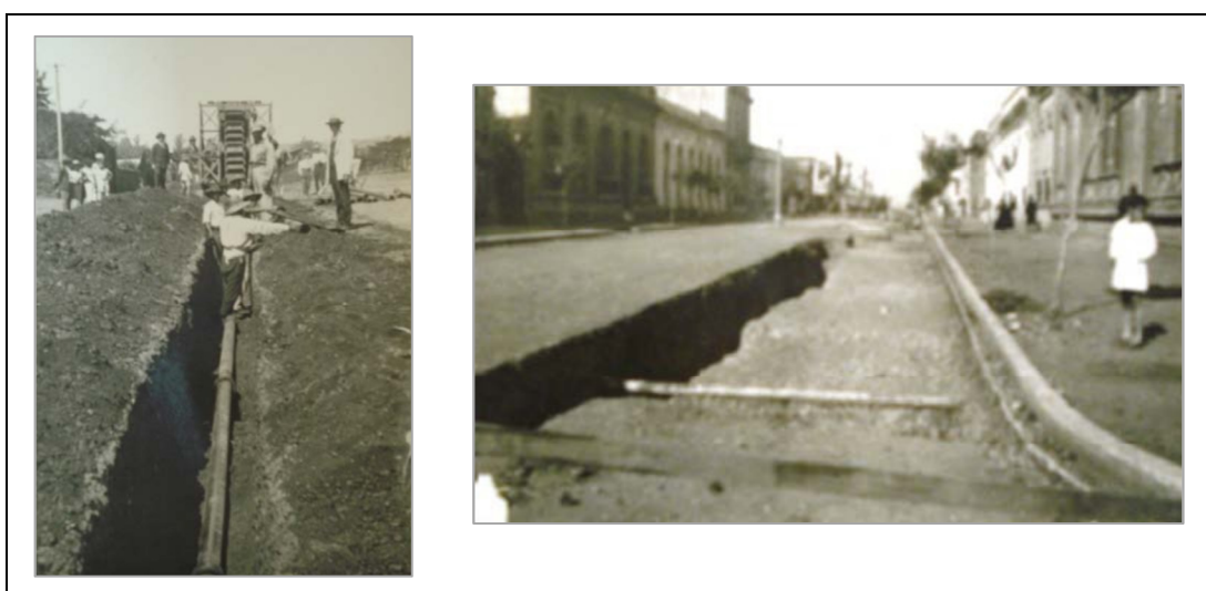
Figura 6.18: Obras de saneamento da cidade de Uruguaiana, 1928 a 1931.
