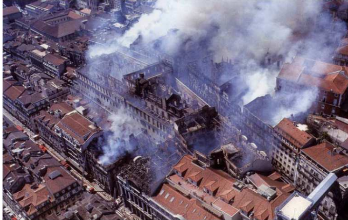
Figura 3 – Vista aérea durante o Incêndio do Chiado em Lisboa, em Portugal, que atingiu 18 edifícios em 1988 (CUNHA, 2010)
