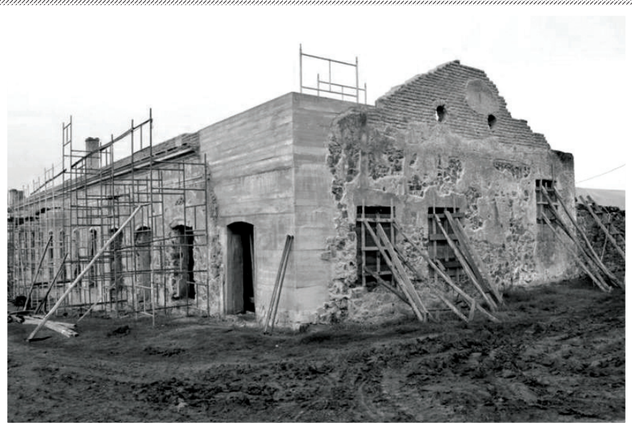
Figura 41 . Construção do CIP em 2013
