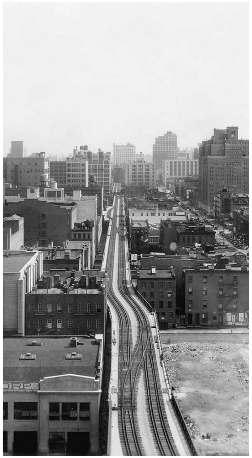
Figura 65 . Imagem aérea da High Line desativada
