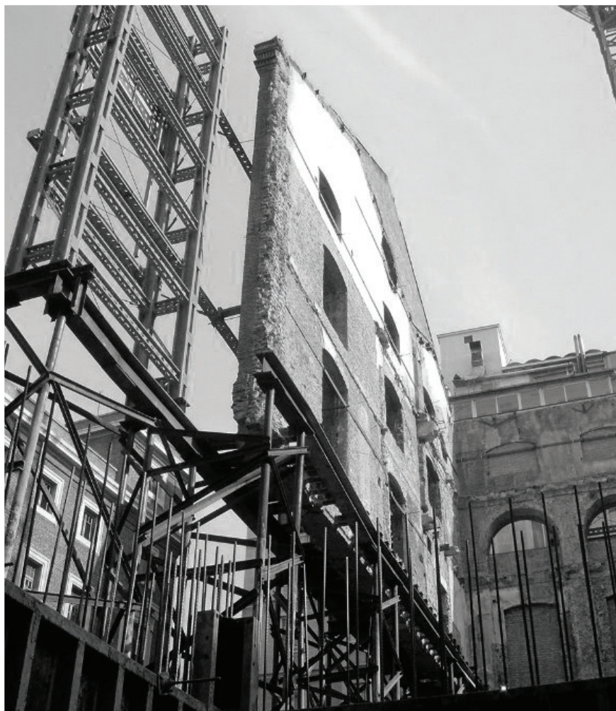
Figura 87 . Fotografias da construção. Fotografia WGG Schnetzer Puskas Ingenieure
