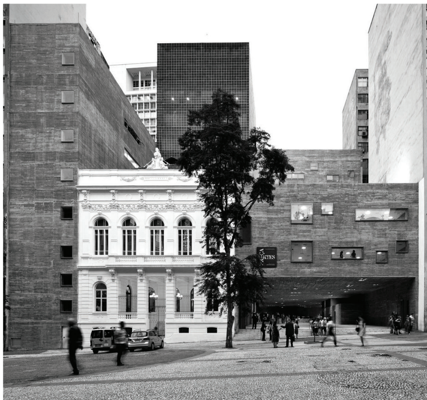
Figura 31 . Vista do acesso pela rua Conselheiro Crispiniano. Fotografia Nelson Kon
