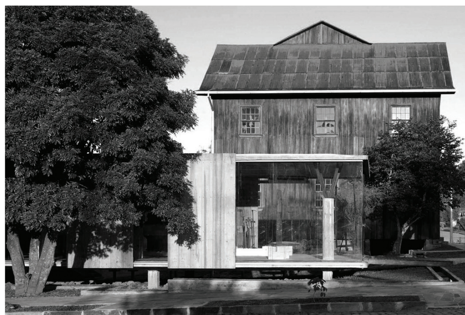
Figura 20 . Fachada sudeste do Museu do Pão, 2008. Fotografia Nelson Kon
