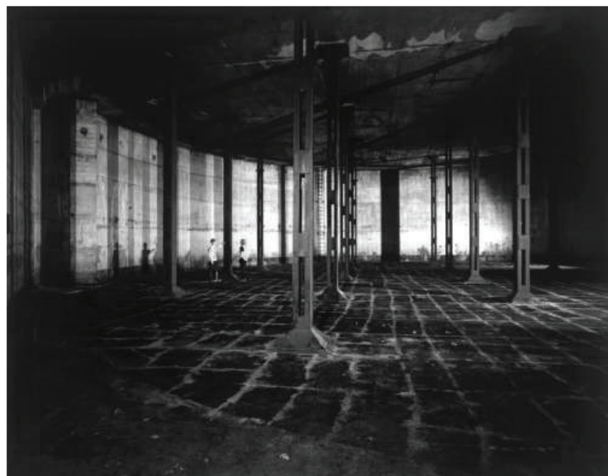
Figura 78 . Interior da Turbine Hall em 1995. Fotografia Peter Marlow
