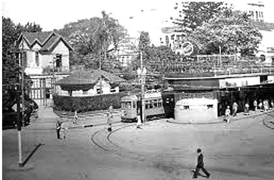
Figura 11. Abrigo de bondes na Praça XV. É uma das mais antigas da cidade e abrigou o primeiro mercado público de Porto Alegre, construído em 1842, e o definitivo, em 1869. Quando ainda não era praça, o local foi primeiro foi chamado de Largo dos Ferreiros, depois Largo Paraíso, em alusão à existência da “Casa do Paraíso”, que a
