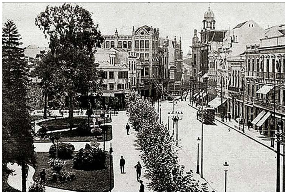
Figura 50. A Praça da Anfândega em 1919. Segundo Franco foi um dos primeiros logradouros a receber atenção por parte do poder público. Data de 1830 as preocupações com a remoção de detritos acumulados nesse local. Dentre os melhoramentos realizados, em 1868 foram colocados bancos no passeio no alinhamento da Rua dos Andradas e o espaço dos despachantes e quitandeiros começava a tomar a forma de jardim público, tendo inclusive um quiosque instalado para as vendas. 351
