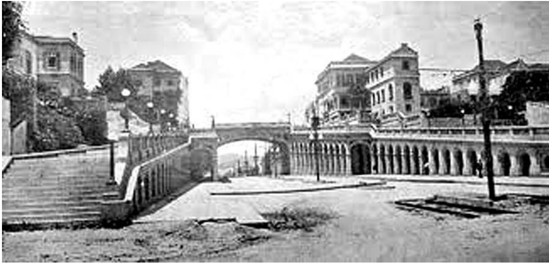
Figura 14. Viaduto Otávio Rocha em 1931. O Viaduto foi executado em estrutura de concreto armado e revestido com cirex (massa raspada com mica), dando-lhe um aspecto de alvenaria de pedra aparelhada. Percebe-se a influência do urbanismo francês em sua arquitetura art nouveau . 184
