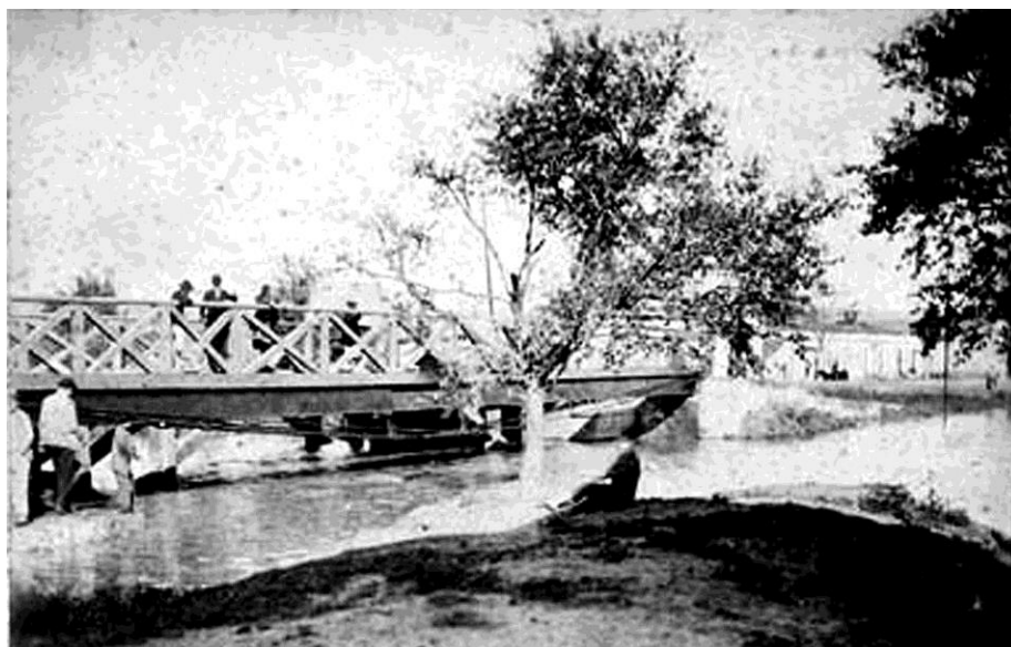
Figura 58. Antiga ponte do Menino Deus na Av. Getúlio Vargas. A partir de 1903 o Menino Deus recebe uma ponte de ferro, com 25m de vão, um estrado de 10 metros de largura, sendo reservados 1,20m de cada lado para passeio e 7,60m para pista de veículos. Em 1935, com as obras de canalização do riacho esta ponte foi desativada, sendo substituída por uma nova no cruzamento sobre o canal. 392
