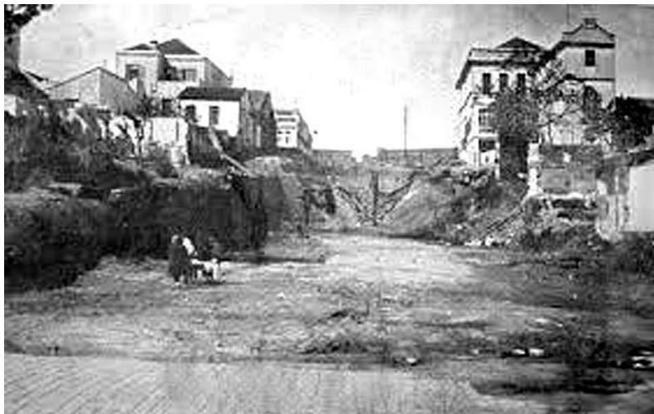
Figura 13. A Av. Borges de Medeiros começa a ser idealizada em 1926. Para concretizar a abertura da avenida foi necessário recortar o espigão que atravessava a área central, ocasionando uma descontinuidade na Rua Duque de Caxias, restabelecida através de uma passagem de nível - o Viaduto Otávio Rocha. 183
