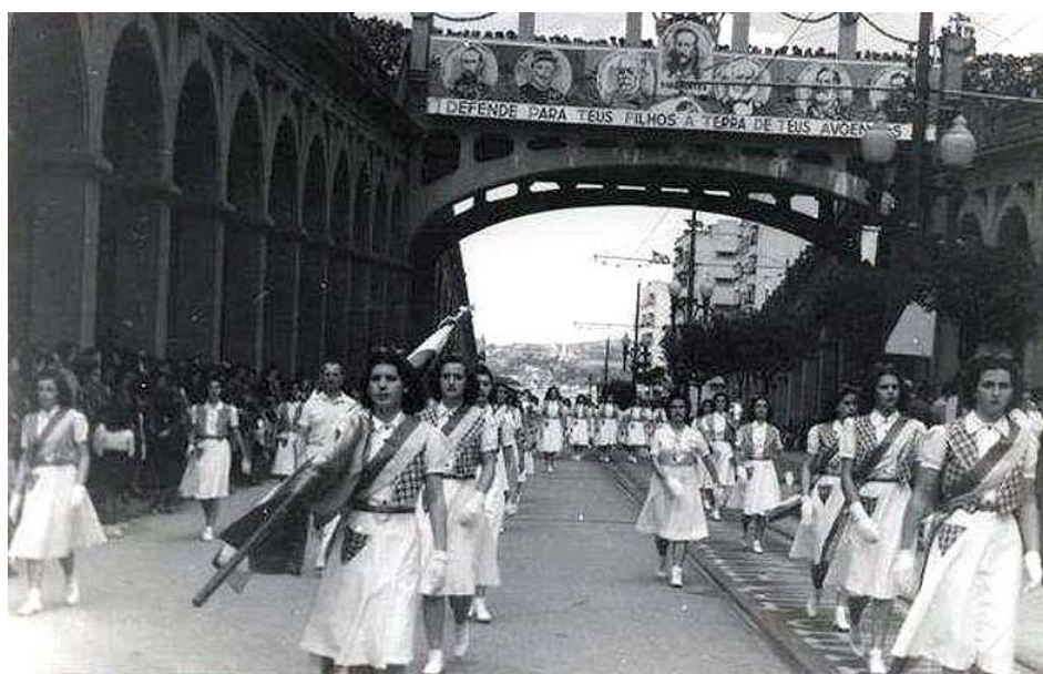
Figura 29. Inauguração do Viaduto Otávio Rocha em 1932 teve caráter monumental.
