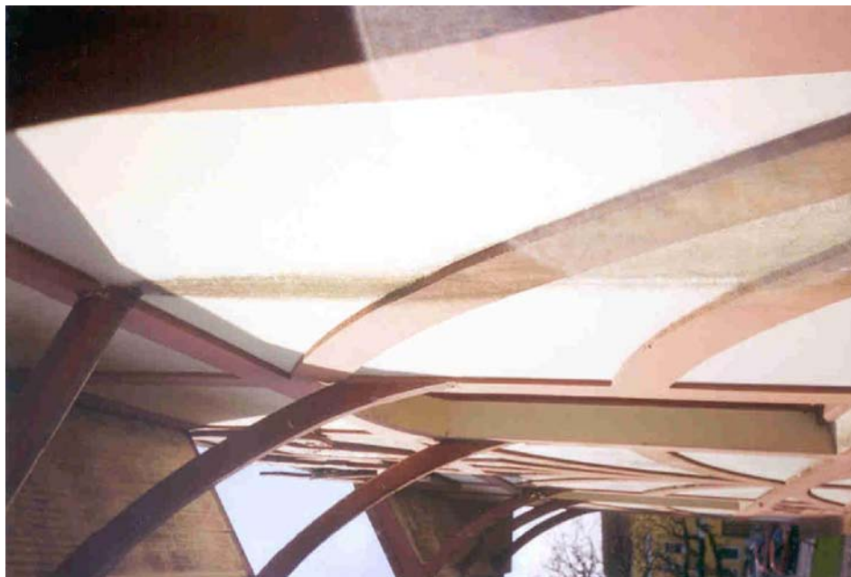
Fig. 75. Belvedere. Detalhe da ornamentação das paredes e apoio da cobertura. (Foto set/2002 - Suzelle Rizzi)
