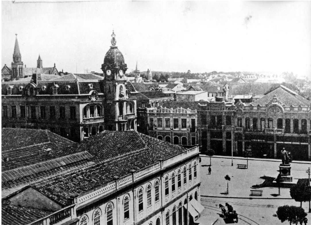
Fig. 11. Vista da praça Generoso Marques. Em primeiro plano a casa Edith, o edifício Tigre Royal em frente e o Paço Municipal no lado esquerdo. Edifícios ecléticos a partir de 1915. (Foto 1916. Acervo Casa da Memória – Curitiba)
