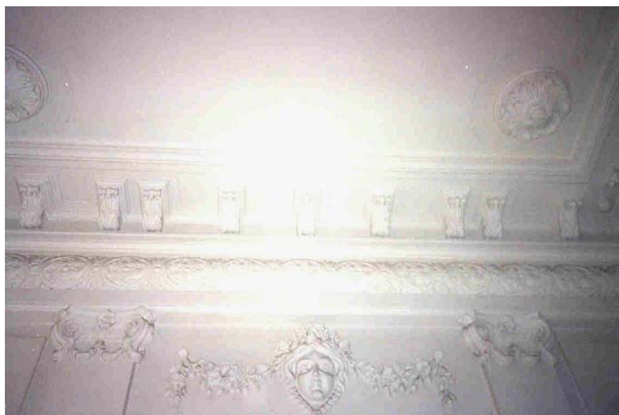
Fig. 102. Paço Municipal. Detalhes e ornamentações na parede interna do hall. (Foto set/2002 - Suzelle Rizzi)
