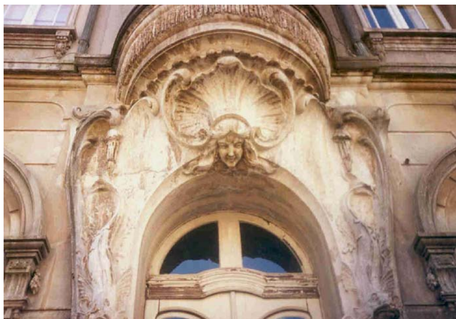
Fig. 88. Paço Municipal. Figura feminina adornando os acessos laterais. Detalhe de apoio da bay window. (Foto set/2002 - Suzelle Rizzi)
