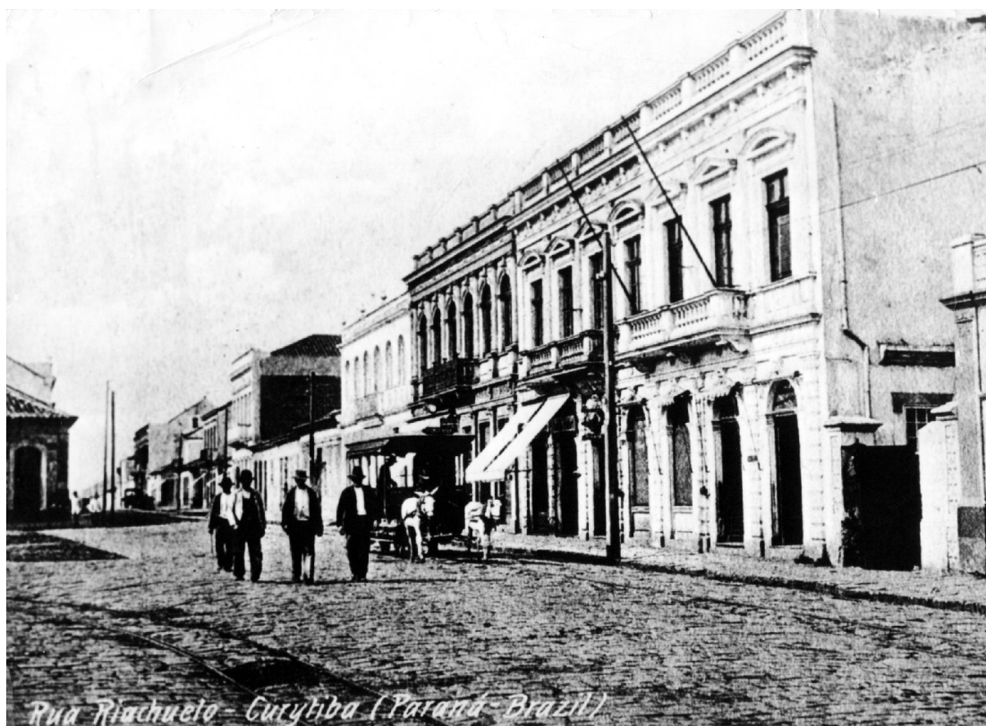
Fig. 20. Rua Riachuelo. Sobrado do Shopping Center Mounif Tacla, onde funcionava no início do século a loja de Frederico Eisendel e a Casa Hertel. Do lado esquerdo aparece a farmácia Araújo. Edifícios ecléticos que primam pelo classicismo. (Foto de 1906. Acervo Casa da Memória – Curitiba)
