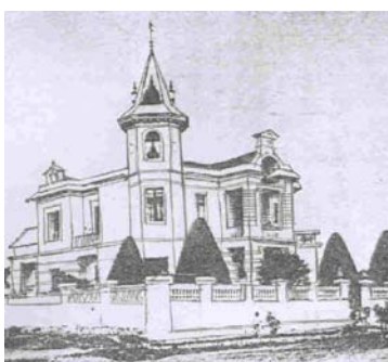
Fig. 03a. Palacete Jorge Eisenbach – 1903. Localizava-se na rua João Negrão, próximo a fábrica Fiat Lux. Residência eclética, precursora das Vilas da década de 20. (Desenho. Boletim Informativo – Rebouças, 1980.)
