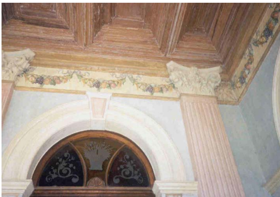
Fig. 54. Palacete Leão Júnior. Acesso lateral secundário. Varanda - ornamentação interna (Foto set/2002 - Suzelle Rizzi)
