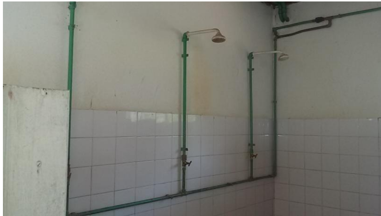
Banheiro Público Feminino Ipanema Foto: Simone Ayala
