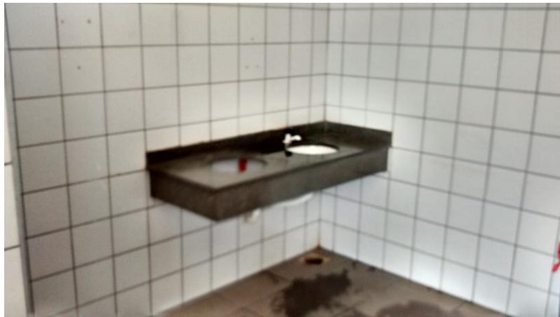
Banheiro Público Masculino Guarujá Foto: Newton Jr
