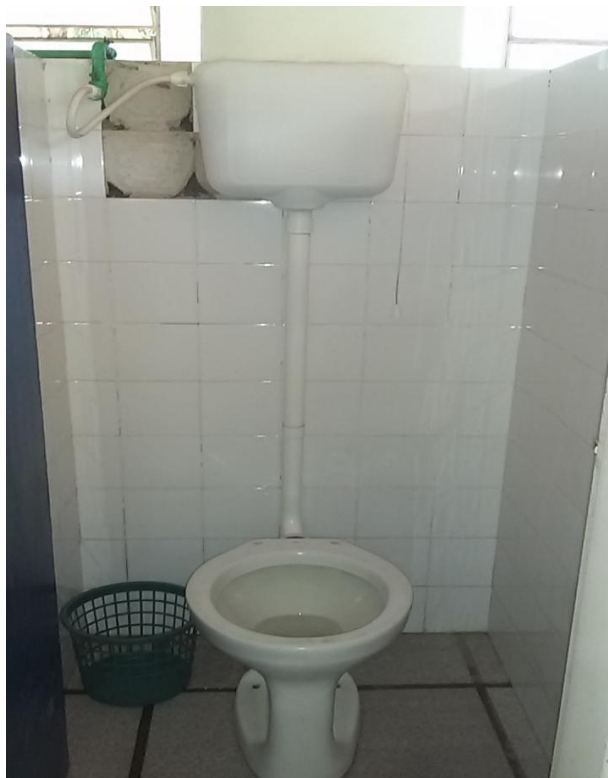
Banheiro Público Feminino Ipanema Foto: Simone Ayala
