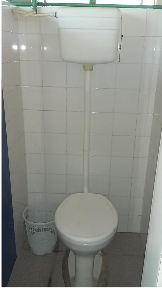
Banheiro Público Feminino Ipanema Foto: Simone Ayala
