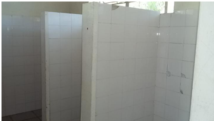
Banheiro Público Feminino Ipanema Foto: Simone Ayala
