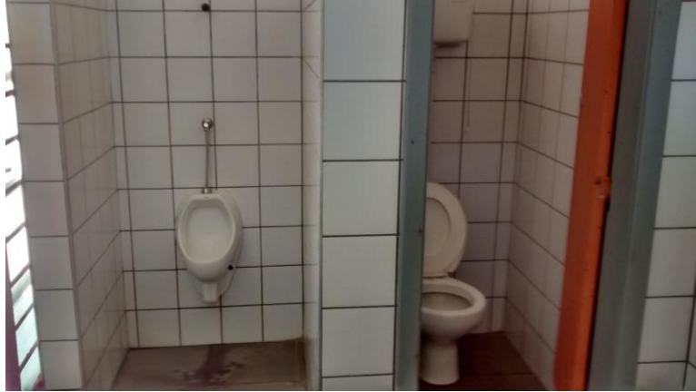
Banheiro Público Masculino Guarujá Foto: Newton Jr
