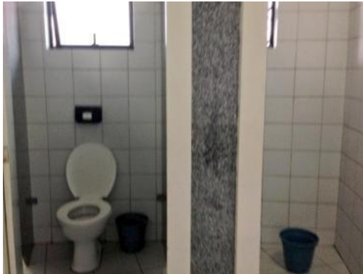
Sanitário do Terminal Triângulo Foto: Evelin Argenta / Rádio Gaúcha
