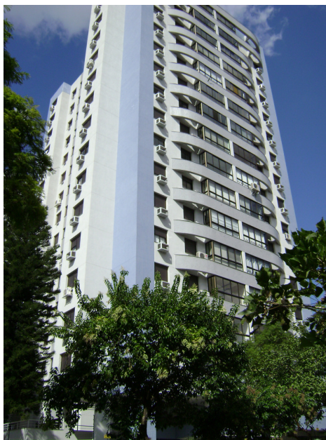
Figura nº 15 - Imóvel localizado na rua Gonçalves Dias nº 170. Fonte: Arquivo Pessoal.
