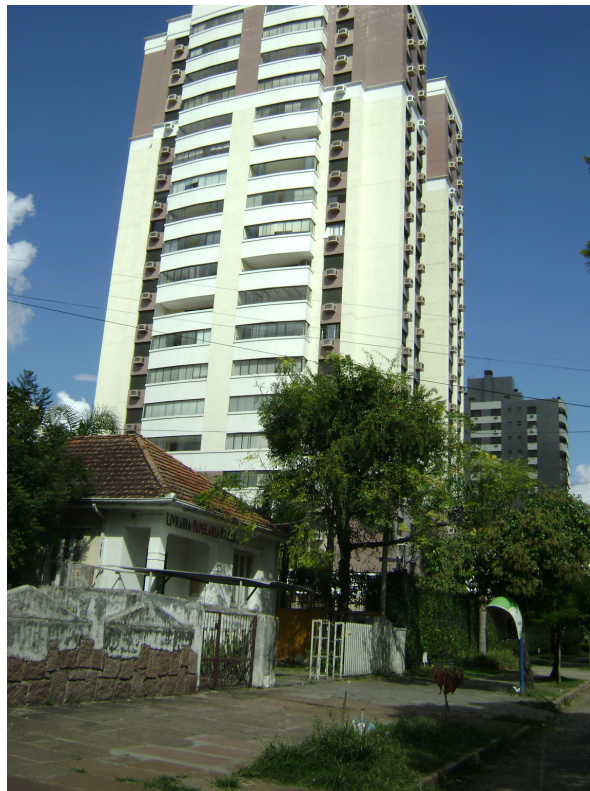
Figura nº 19 - Rua Gonçalves Dias nº 342. Fonte: Arquivo Pessoal.
