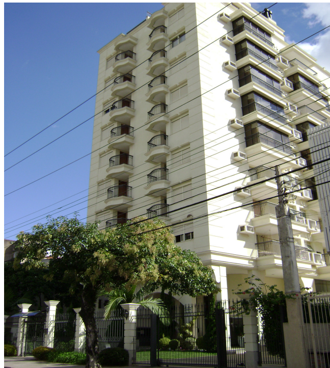
Figura nº 1 - Rua Gonçalves Dias nº 319. Fonte: Arquivo Pessoal.
