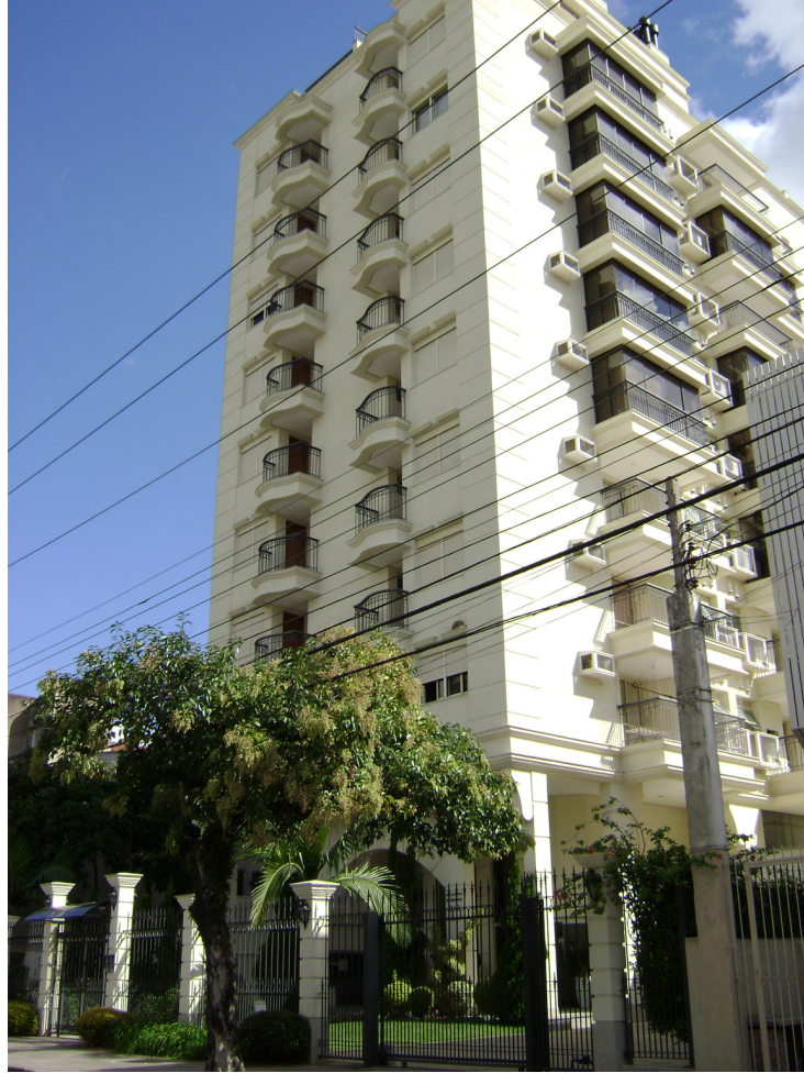
Figura nº 17 - Rua Gonçalves Dias nº 319. Fonte: Arquivo pessoal.
