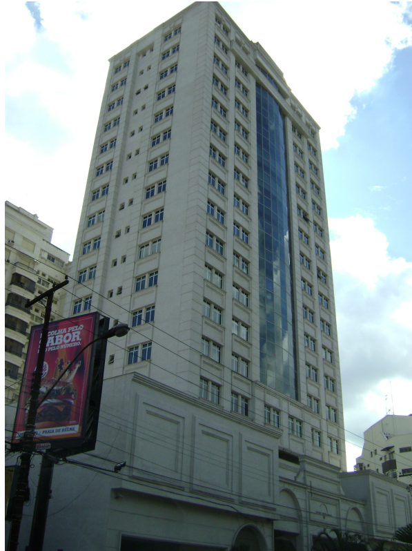
Figura nº 27 - Vista do prédio comercial da avenida Getúlio Vargas nº 901. Ao fundo, uma das torres do prédio residencial deste empreendimento. Fonte: Arquivo Pessoal.
