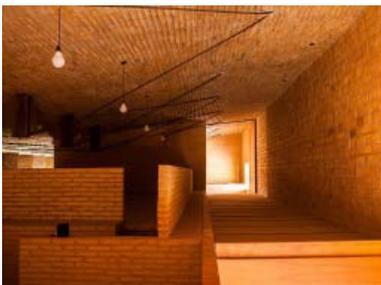
As pirâmides invertidas que cobrem o bloco de hidroterapia da Fundação Teletón também foram construídas em alvenaria armada. Ao contrário dos casos anteriores, os tijolos foram assentados de cutelo e aparelhados com juntas a prumo (Fig.
