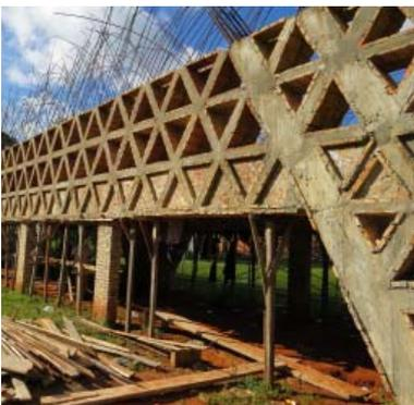
Na antiga sede do Gabinete de Arquitectura (1994) as superfícies de texturas áspera são obtidas com tijolo maciço inteiro assentado de cutelo ou ao comprido com generosas juntas de argamassa salientes (Fig. 6.122). A textura bruta das lajes e forros dos ambientes são obtidas com tijolo maciço quebrado assentado a peripiano ou ripas de madeira instalada sem preocupação com alinhamento ou encaixes entre as peças.
