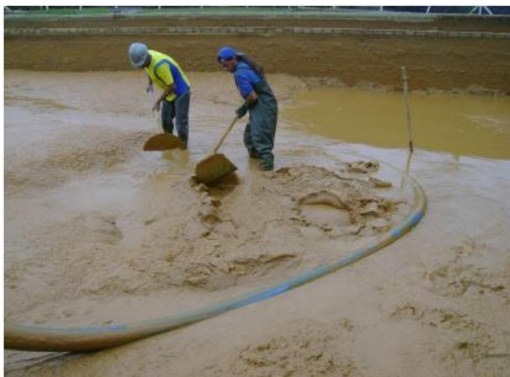
Figura 23: Lodo férrico resultante da Neutralização da DAM (Silva, R.D., 2009)
