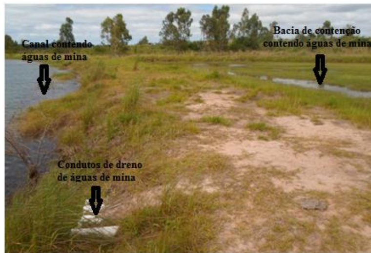
Figura 30: À esquerda, o canal contendo DAM formada na interação entre água, oxigênio e rejeitos de carvão, e à direita, uma bacia de contenção de água do primeiro canal.
