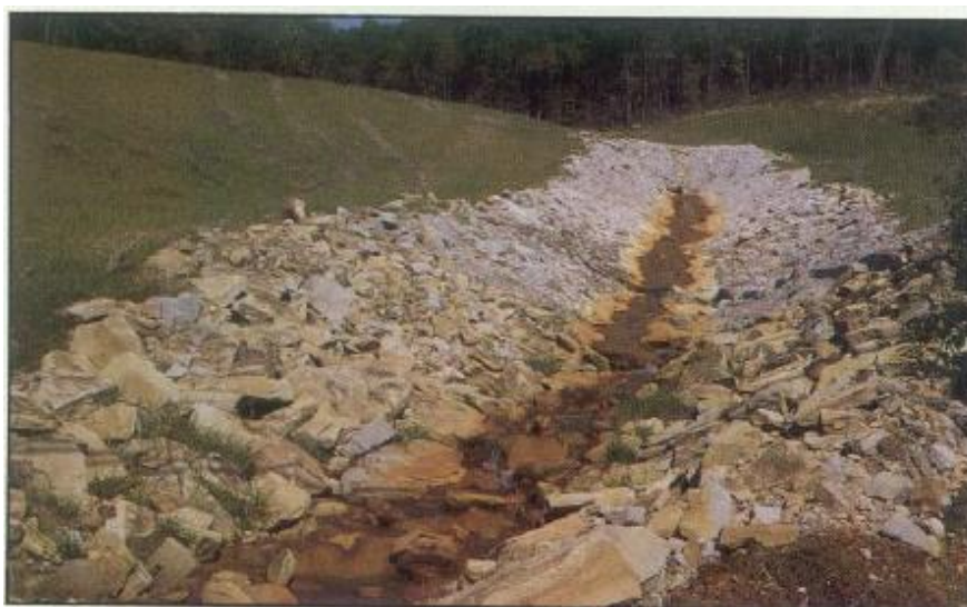
Figura 22. Retrato de um canal de calcário aberto construído (Ziemkiewicz et al., 1994)
