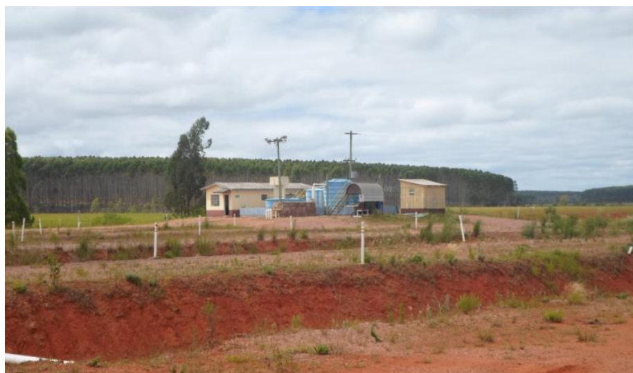
Figura 25. Estação de tratamento de efluentes e respectivas bacia de sedimentação de flocos de DAM tratada em método de neutralização e Floculação (sistema ativo) e – Capão da Roça, COPELMI/RS (2014).
