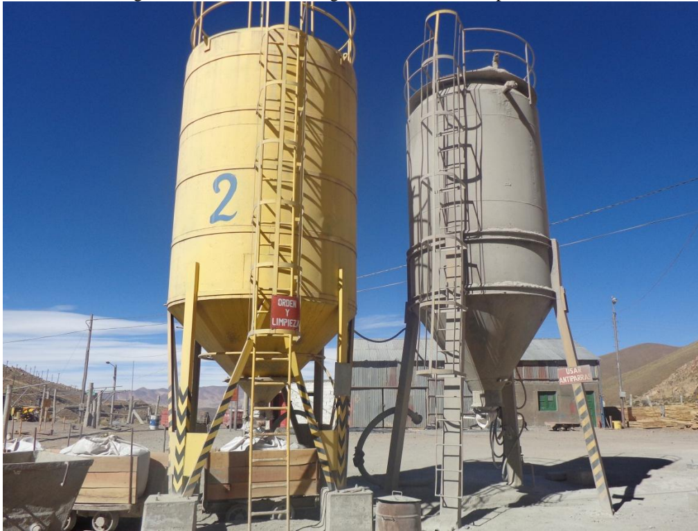
Figura 5 - Silos de armazenagem de cimento em superfície
