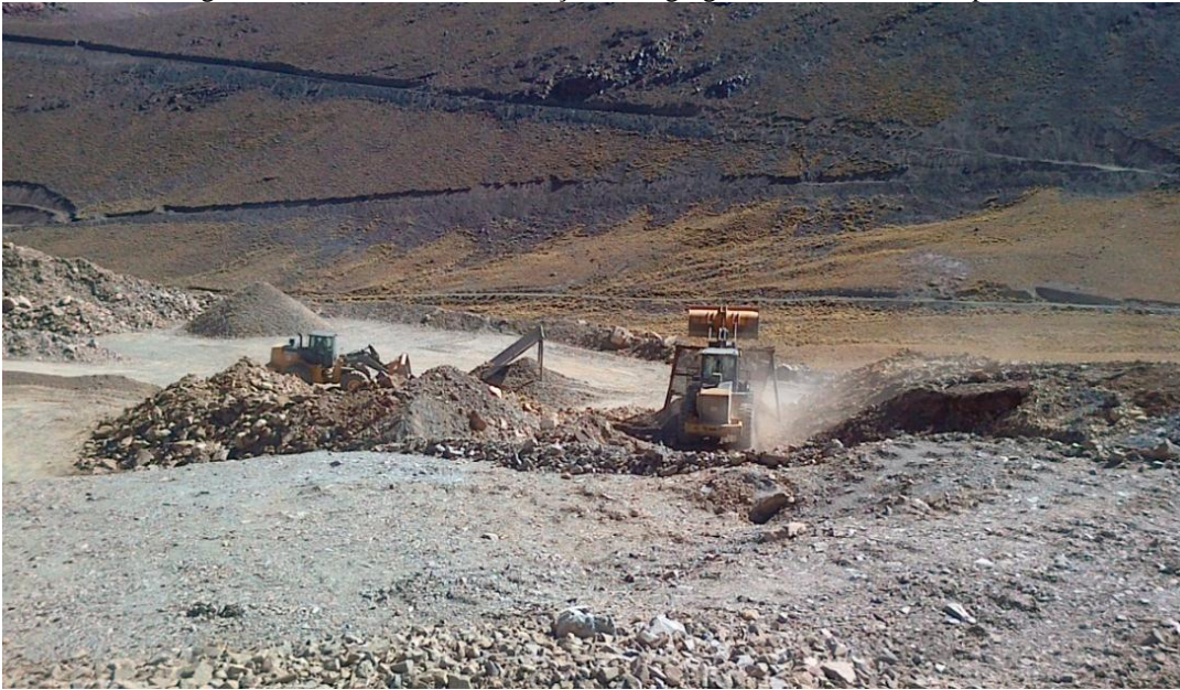
Figura 3 - Processo de classificação dos agregados no nível 2 em superfície
