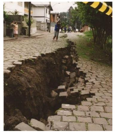
Bairro Cruzeiro – ruptura causada por corte do talude a jusante<sup>3</sup>
