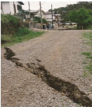
Bairro Cruzeiro – ruptura na via causada por desestabilização em virtude de corte do talude a jusante<sup>3,2</sup>
