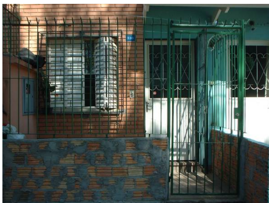
Figura 152 – Sobrados do EHIS Progresso localizados junto à diretriz 607 em 12/2004
