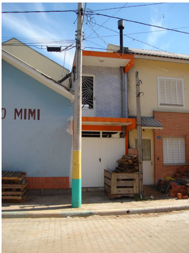
Figura 145 – Exemplo de ampliação de 2 pavimentos realizada em pátio de UH do EHIS Progresso (11/2006)
