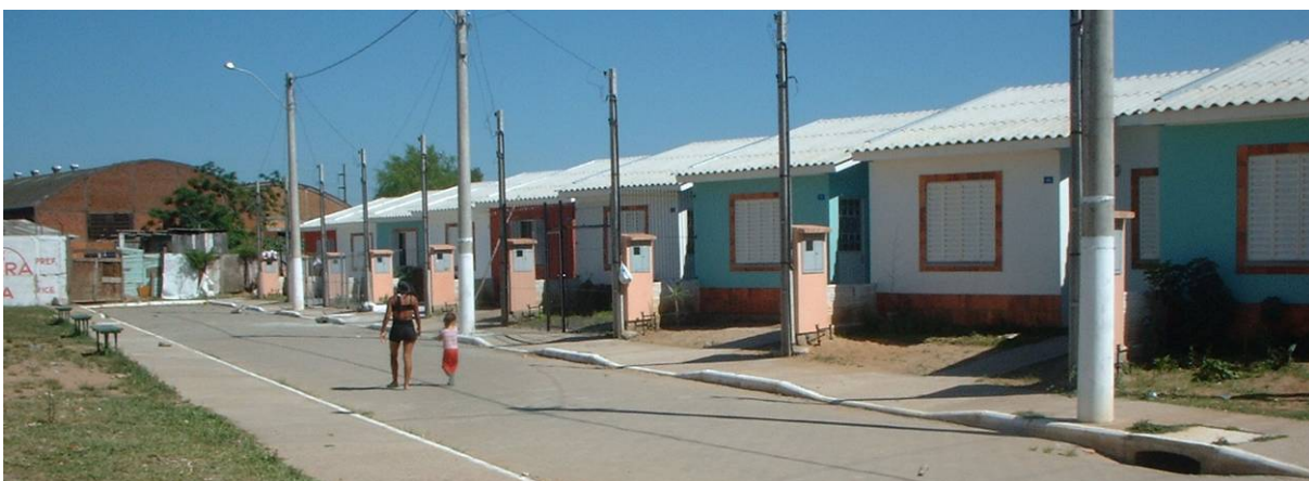
Figura 26 – Casas Térreas do EHS Progresso em 12/2004
