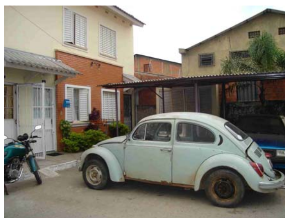
Figura 121 – Exemplo de acessório de proteção horizontal (cobertura de garagem) realizado em UH do EHIS Pôr-do-Sol (11/2006)
