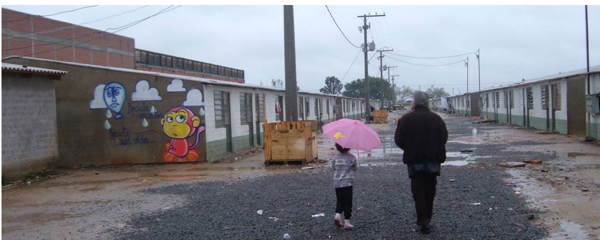
Figura 90 – Casas de Passagem ocupadas pelos moradores do extinto Assentamento Subnormal Vila dos Papeleiros em 09/2005, durante as obras do EHS Santa Terezinha
