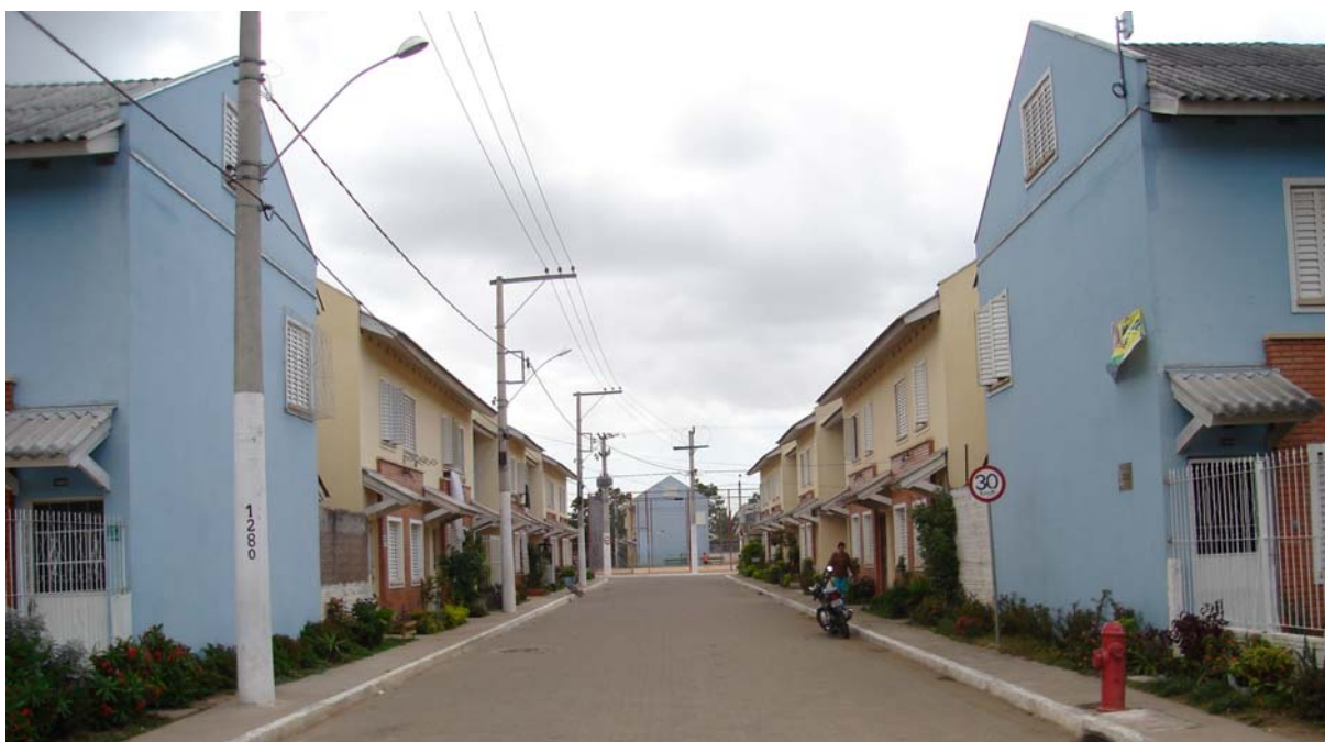
Figura 126 – Foto da rua de acesso ao EHIS Pôr-do-Sol (11/2006)
