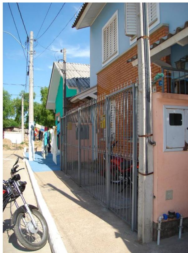
Figura 146 – Exemplo de colocação de acessório de proteção (grades) no EHIS Progresso (11/2006)
