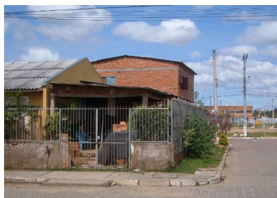
Figura 105 – Exemplo de acessórios de proteção vertical (grade e muro) e horizontal (cobertura de garagem) realizados em UH do EHS Vila Tecnológica (01/2005)
