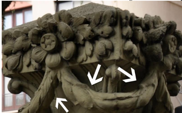
Figura 53: Detalhe dos ornamentos que foram reconstruídos digitalmente em sua parte interna.
