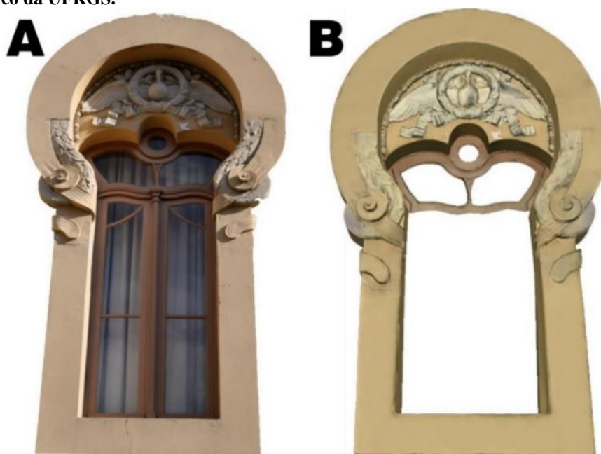
Figura 42: Comparação entre a fotografia e o modelo virtual em 3D da janela do Observatório Astronômico da UFRGS.
