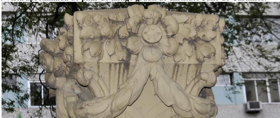
Figura 52: Vista aproximada do pilar do antigo gradil do Instituto Júlio de Castilhos.
