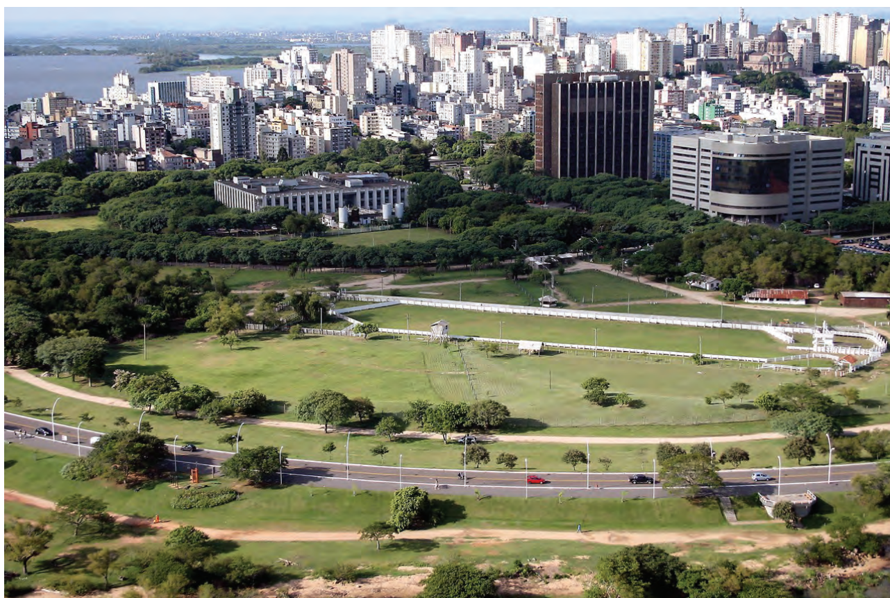
vista aérea da testada sudoeste da área de intervenção
