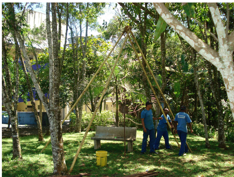
Figura 5.3: Equipamento SPT montado.
