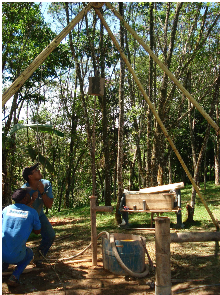
Figura 5.19: Execução do ensaio 2,0 SPT.
