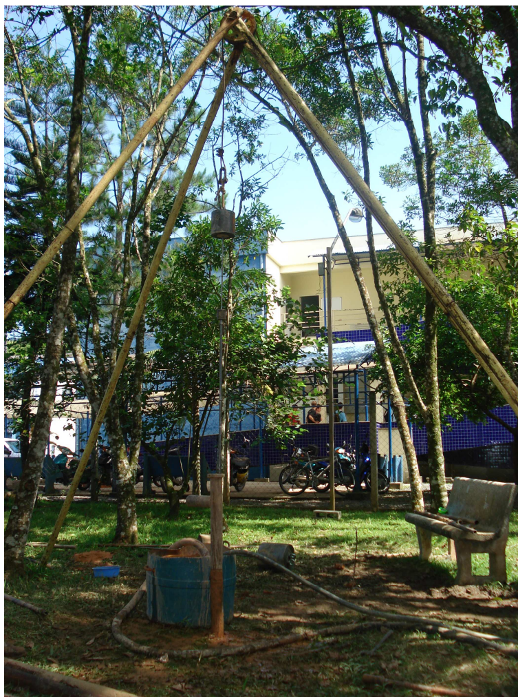
Figura 5.18: Execução do ensaio 0,5 SPT.
