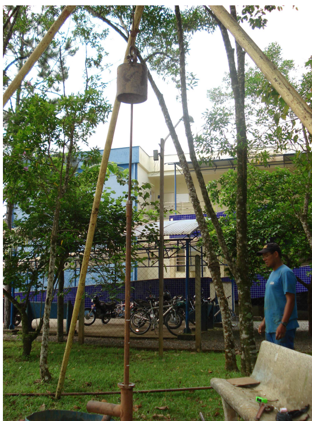
Figura 5.14: Processo de cravação do amostrador-padrão.
