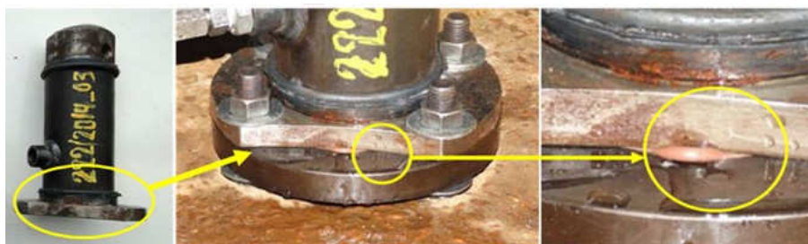
Figura 4-28 Local do dano na vedação para os conjuntos soldados no processo Fricção
