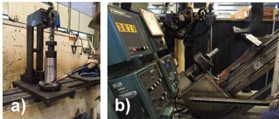
Figura 3-9 Soldagem MAG entre o flange e o tubo a) Solda ponto b) Solda fechamento a 45°
