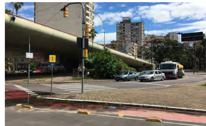
Av. João Pessoa | Fim do Viaduto
