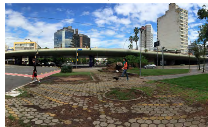
Av. João Pessoa | Viaduto passando Av. Loureiro da Silva
