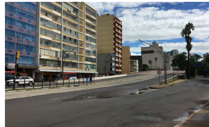
Av. João Pessoa | Início do Viaduto
