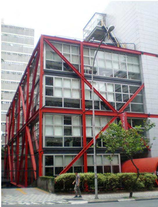
Escola Panamericana de Arte e Design São Paulo-SP ZANETTINI ARQUITETURA -Utilização da estrutura metálica em destaque.
