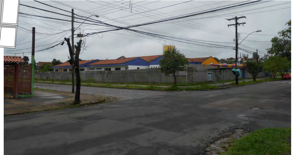
FOTO 3 - acesso da EMEI
