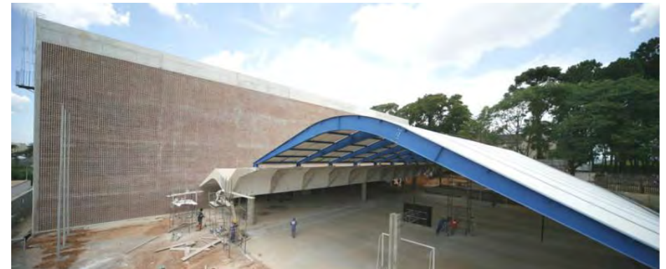
E.E. Centro Poá, SP F. PETRACO ARQUITETOS - Proteção solar em cobogós pré-fabricado e cobertura metálica.
