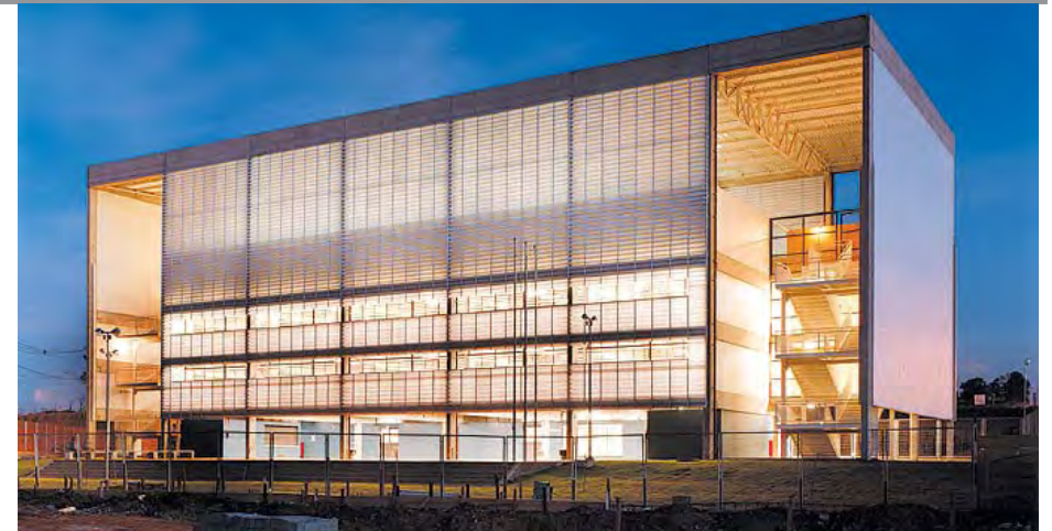
Escola de ensino fundamental, Campinas-SP UNA ARQUITETOS -Estrutura pré-moldada em concreto e proteção de incidência solar direta por brises metálicos.
