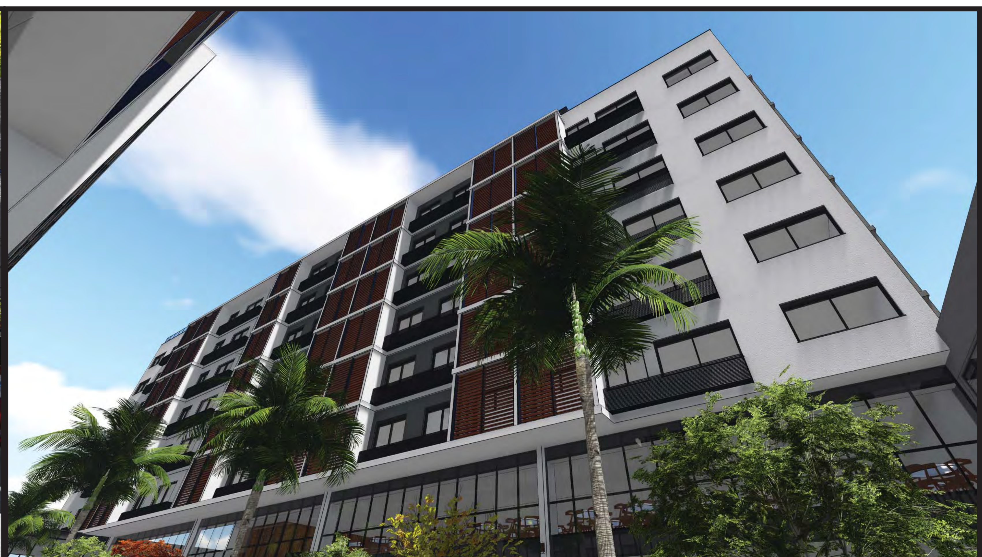
Imagem 15 fachada do residencial vista da praça
