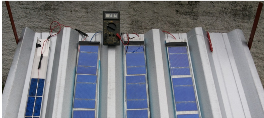
Figura 48 : Medição da junção de 3 calhas fotovoltaicas do layout novo
