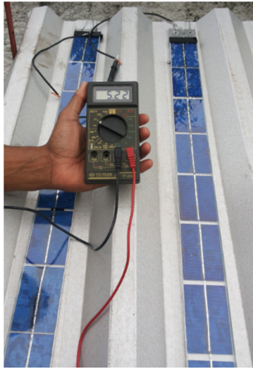
Figura 29 : Forma de medição da tensão da calha fotovoltaica
