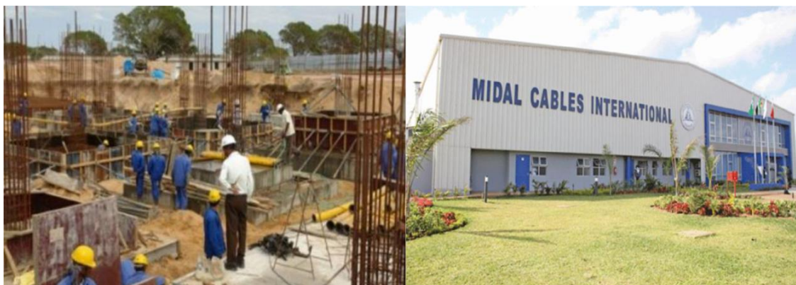
Figura 12. 1ª fase da construção da fábrica de produção de varões de alumínio, fios, cabos elétricos e seus derivados a Midal Cables Internacional.
