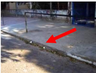
**Figura 17: Entorno da E.M.E.F. Monteiro Lobato: meio-fio sem rebaixamento**
