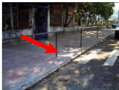
**Figura 18: Entorno da E.M.E.F. Monteiro Lobato: meio-fio sem rebaixamento**
