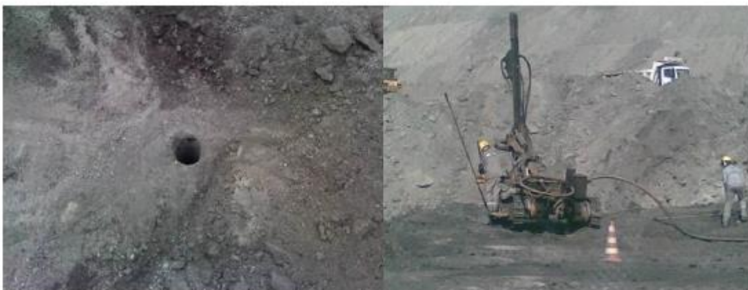
Figura 24 - (A) e (B): Furo de desmorte e perfuratriz de desmorte respectivamente.
